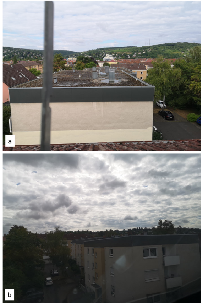
Abb. 7: Blick auf Dächer bzw. Attikaverkleidung am 23.07.2025. a: Dach Neubergstrasse 50b. b: Dach Neubergstrasse 50d. (Quelle: Nadja Stingl-Sinn)
