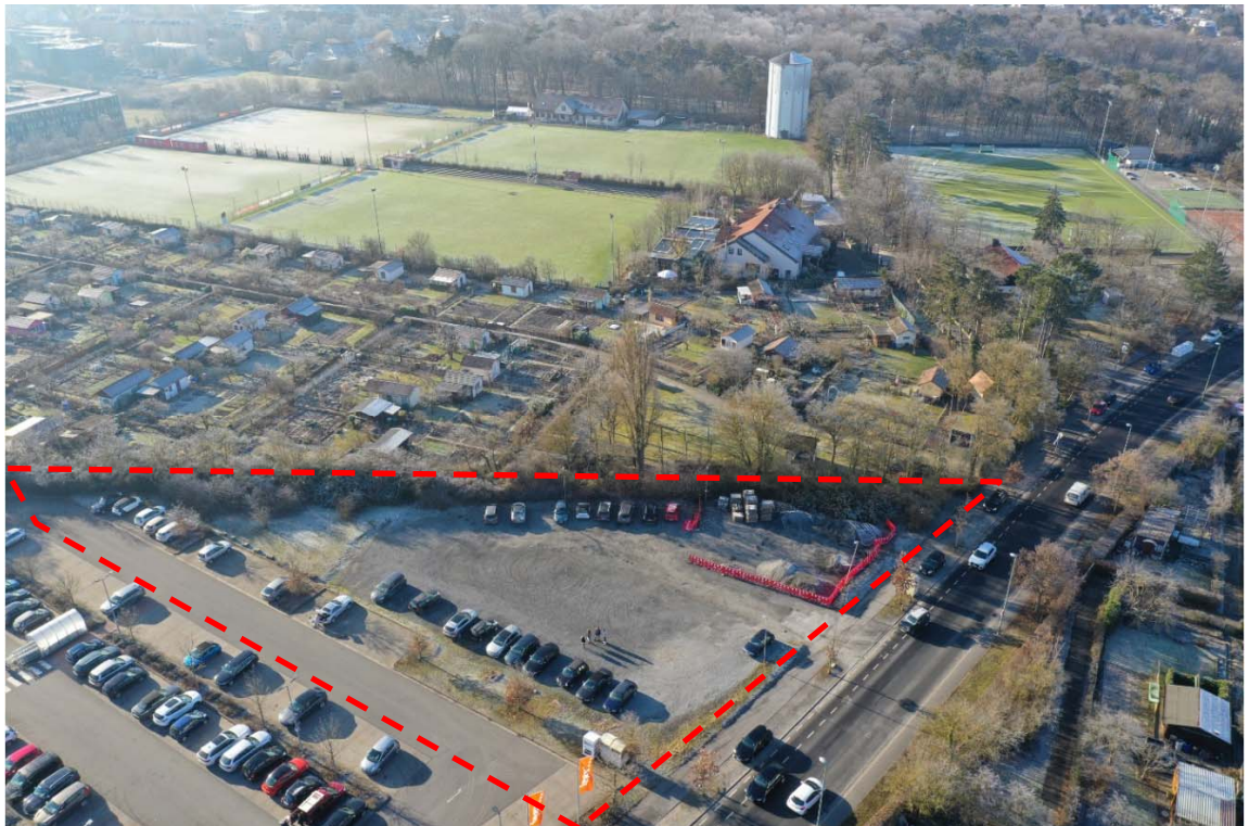
Abbildung 4: Schrägluftbild Blickrichtung Südwesten, grobe Abgrenzung (Quelle: BA Projekt GmbH & Co. KG)
