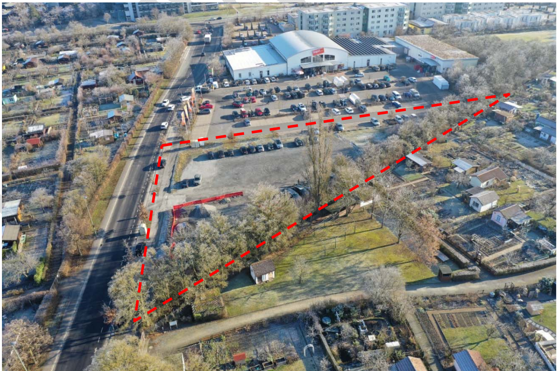
Abbildung 5: Schrägluftbild Blickrichtung Osten, grobe Abgrenzung (Quelle: BA Projekt GmbH & Co. KG)
