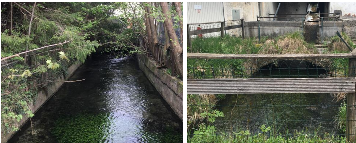
Abb. 18 Krebsbach mit bestehendem U-Profil und Überbauung
