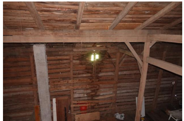
Abbildung 9: Potenzielle Einflugmöglichkeit ins Scheinen innere aufgrund gebrochener Außenverkleidung.
