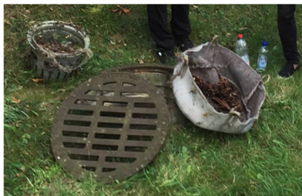
Abbildung 34: Aufbau Nassschlammfang DN450, Filtersack im Muldenüberlauf (Scharnh.Park, HL)
