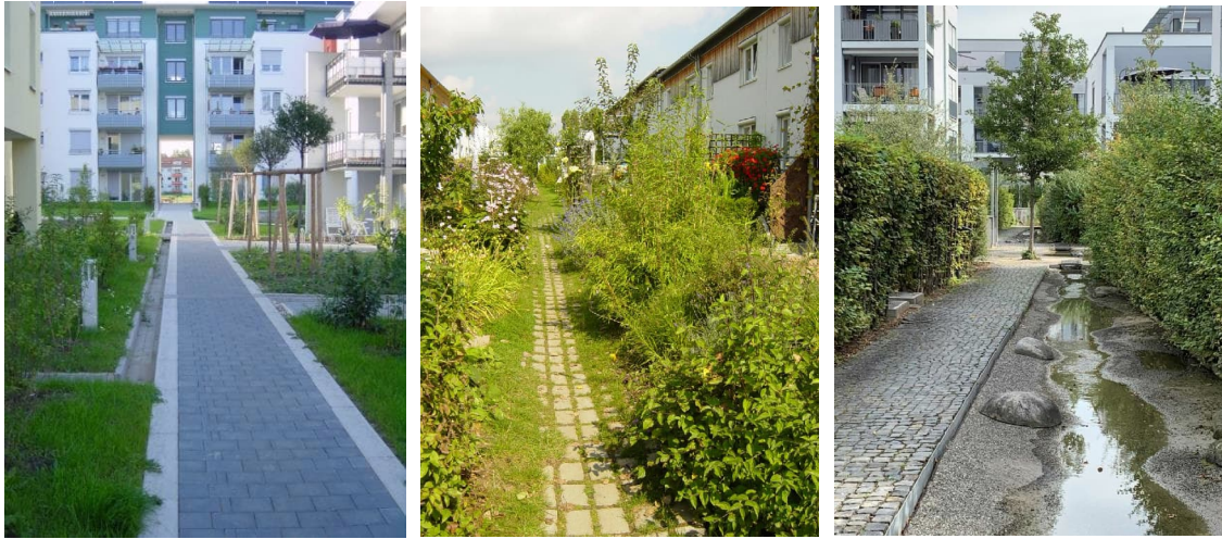
Abbildung 31: Private Ableitung über mehrere Grundstücke (Scharnhäuser Park, Ostfildern, HL)
