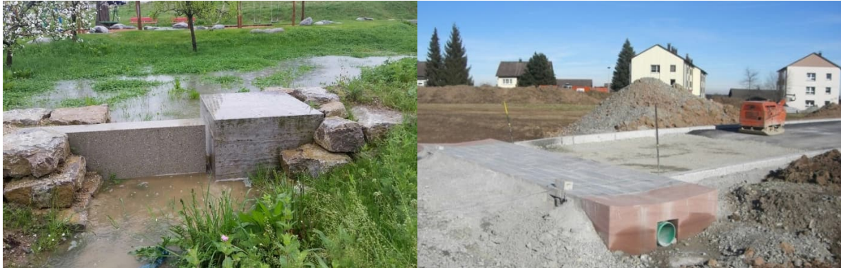
Abbildung 38: Schlitzdrossel und Rohrdrossel (EQP Pfaffenhofen, Im Sulgen Schramberg, HL)
