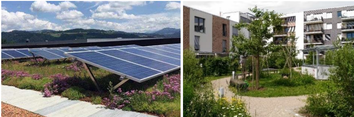
Abbildung 16: Beispiele extensiver Dachbegrünung mit PV und intensiver begrünter Tiefgaragendecke (HL)
