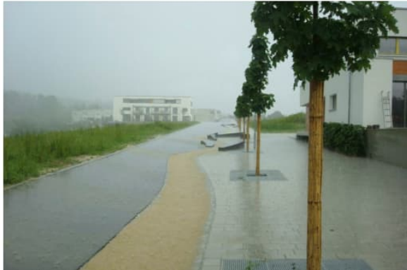
Abbildung 49: Ableitung eines Starkregenereignis über eine Rinne im V-Profil (Sonnensiedlung Esslingen-Egert, HL)
