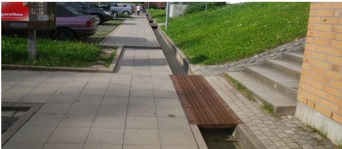
Abbildung 30: Öffentliche Kastenrinne (offen) für Grundstücks- und Straßenentwässerung (Scharnh.Park, HL)
