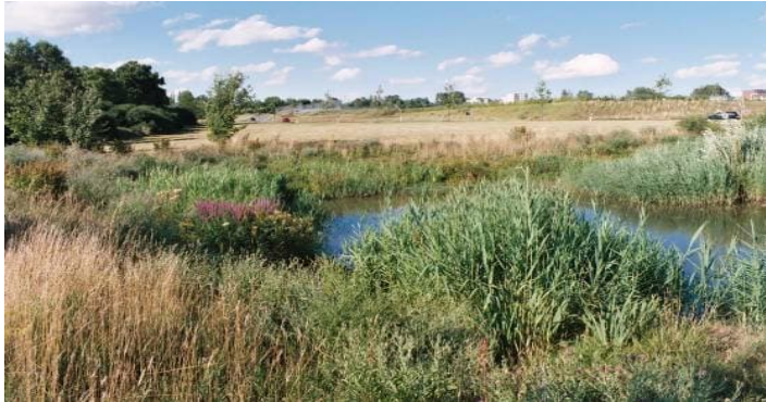
Abbildung 37: Regenrückhalte- und Klärbecken naturnah (Scharnh. Park, Ostfildern, HL)
