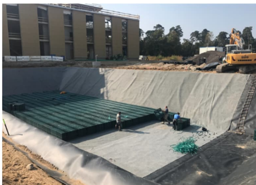
Abbildung 20: Kunststoffrigole als Speicher in der Bauphase (HL)
