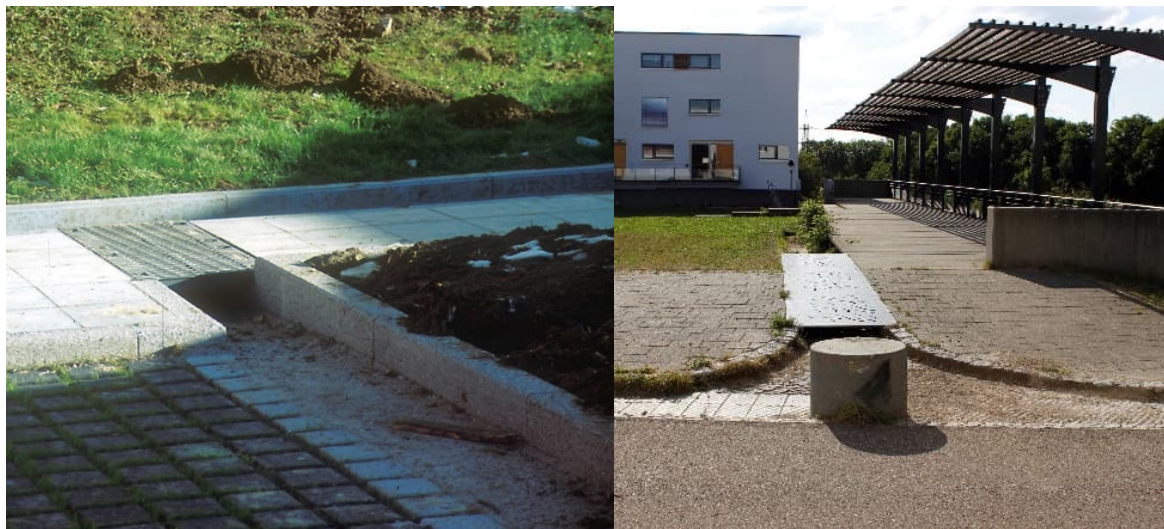
Abbildung 28: Abschlag mittels Kastenrinne (Scharnhäuser Park, HL)/ abgedeckter Kastenrinne über Gehweg (Esslingen Egert, HL)
