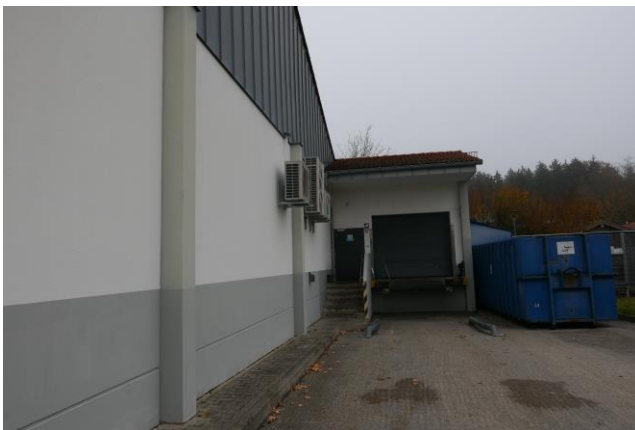
Abbildung 10: Teilverkleidung der Außenmauer Aluminiumsegmenten.
