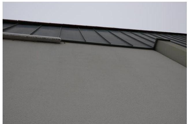
Abbildung 11: Die Verkleidung der Außenmauer weist keine für Fledermäuse nutzbaren Spalten auf.
