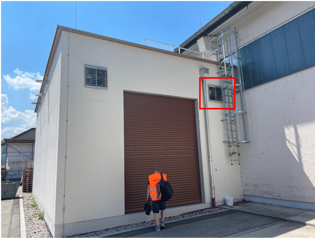
Bild 1: Ansicht Halle Kompressor von Norden
