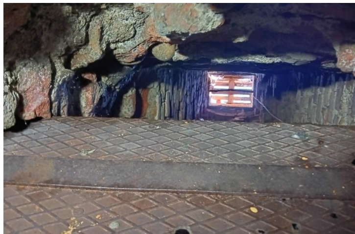
Blick auf einen Lüftungsschacht des Kellers.
