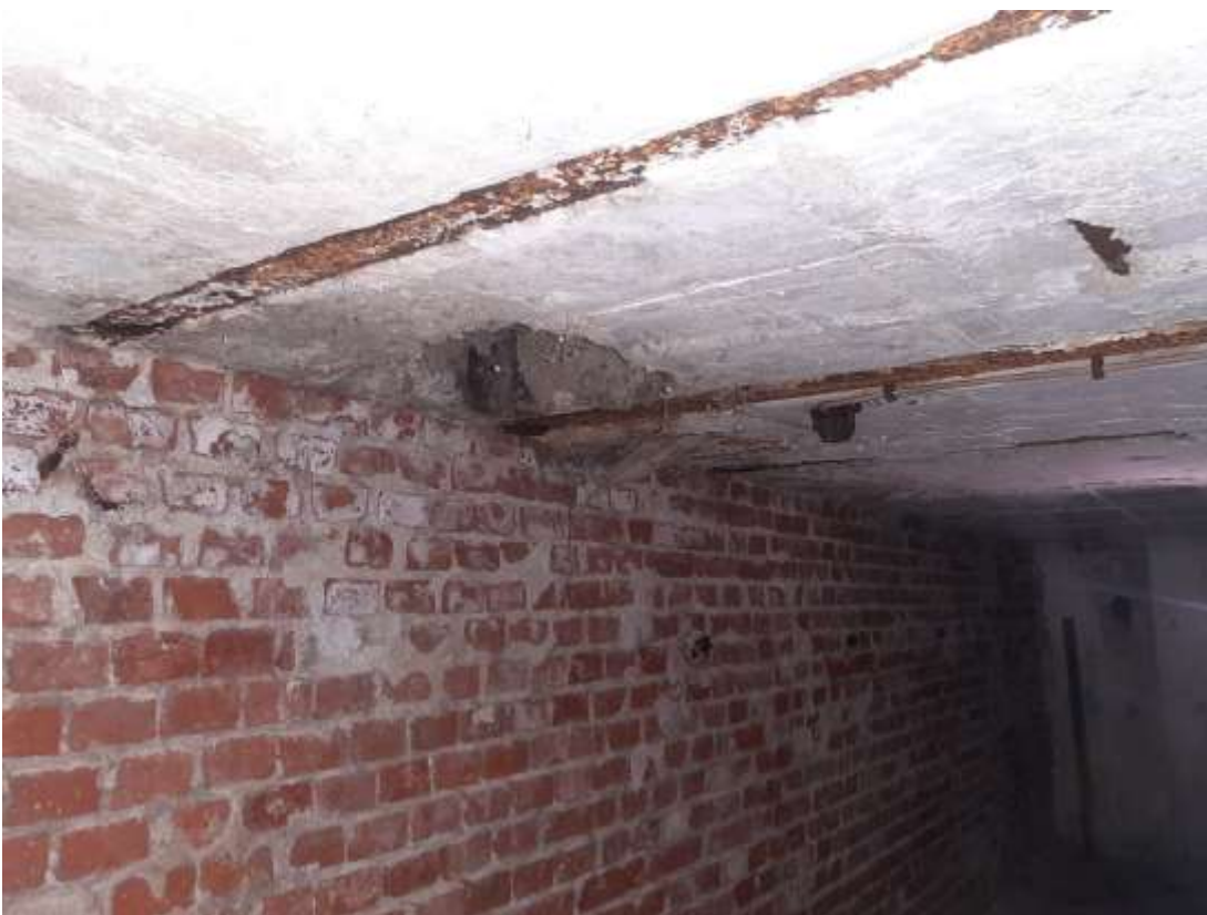
Abbildung 4: Keller – Übersicht und Decke
