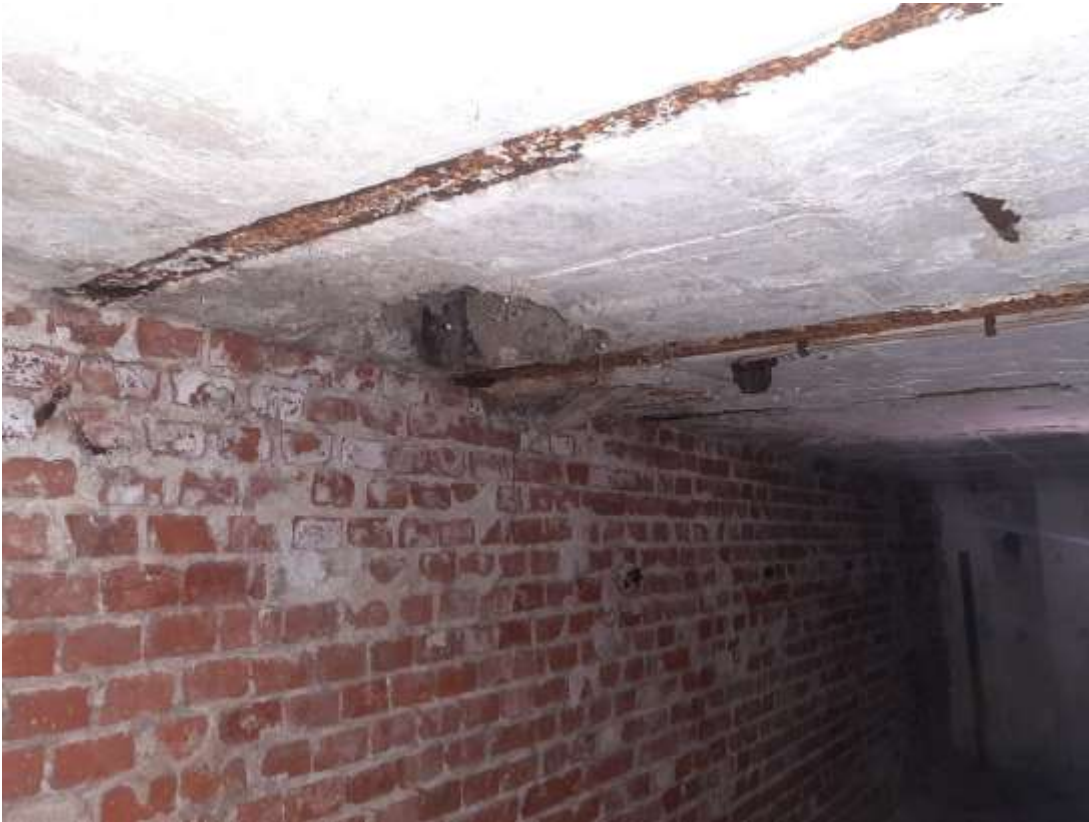
Abbildung 9: Keller – Übersicht und Decke
