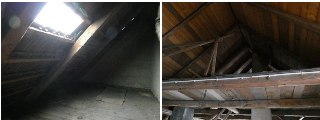
Abb. 13: Blick in die Dachstühle des Wohngebäudes
