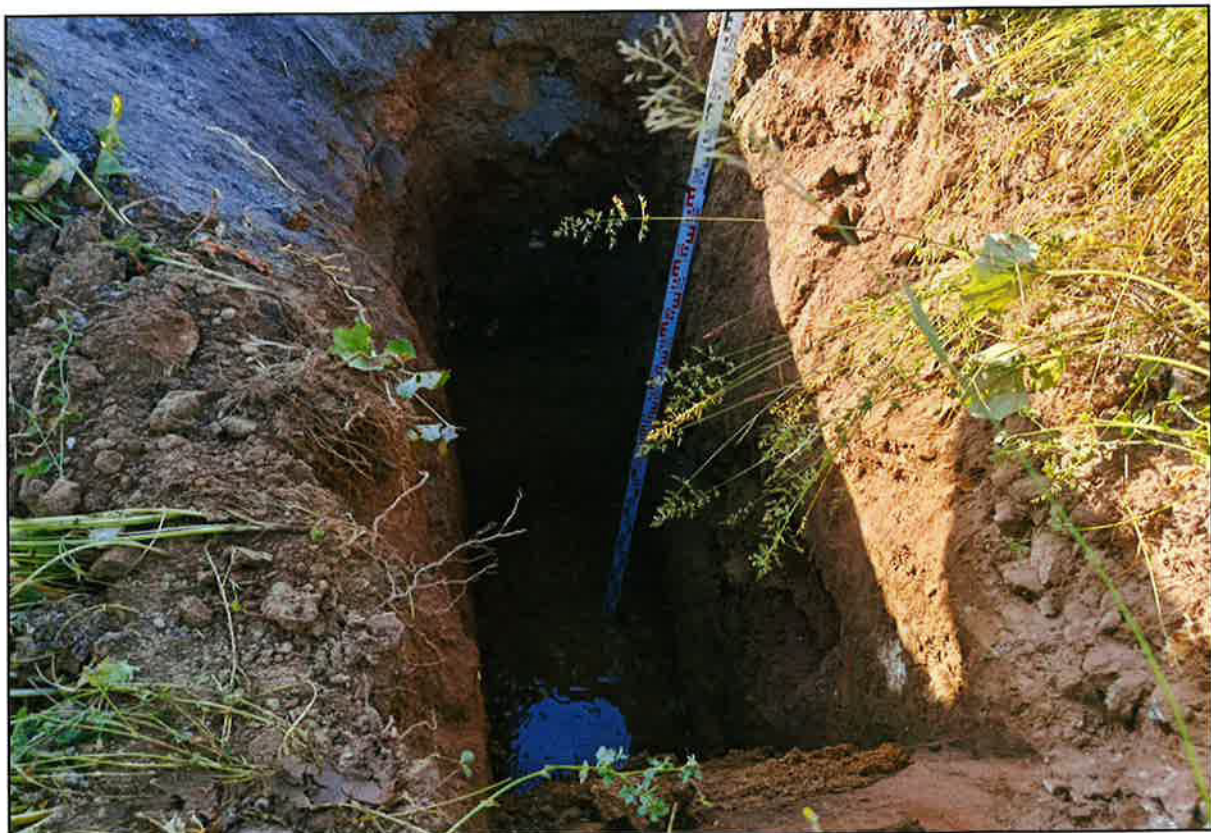
Abb. 1: Baggerschurf BS 26-1 mit Grundwasseranschnitt bei 2,3 m uGOK; Aufnahme vom 25.06.2026
