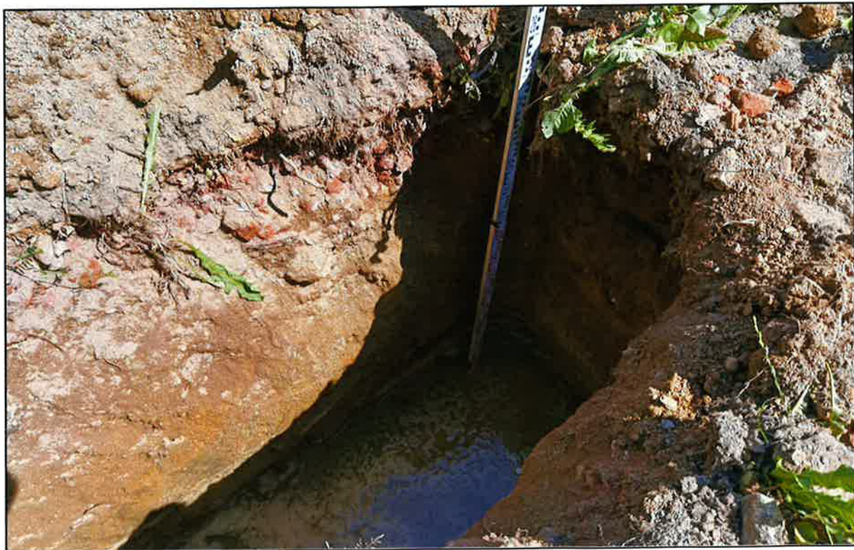
Abb. 3: Baggerschurf BS 26-2 während des Sickerversuchs; Aufnahme vom 25.06.2026
