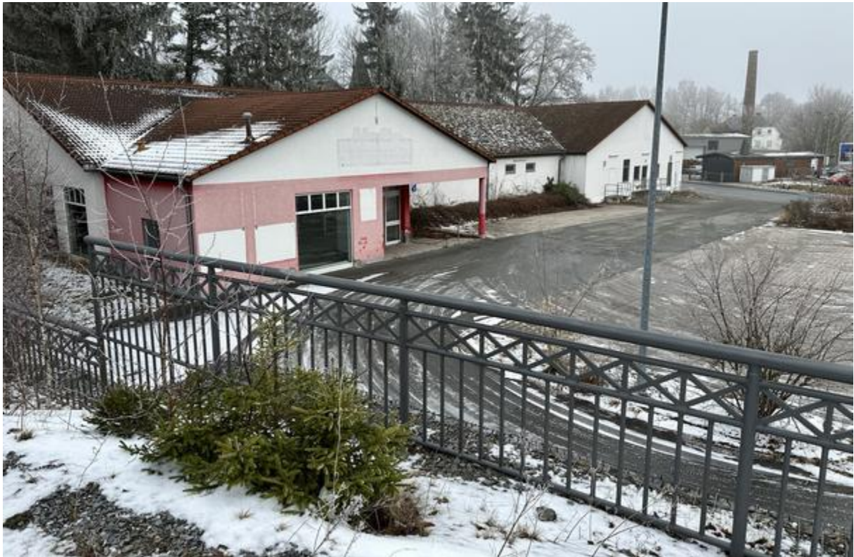
Abbildung 55: Gebäude, von der Bergstraße (Süden) aus betrachtet.
