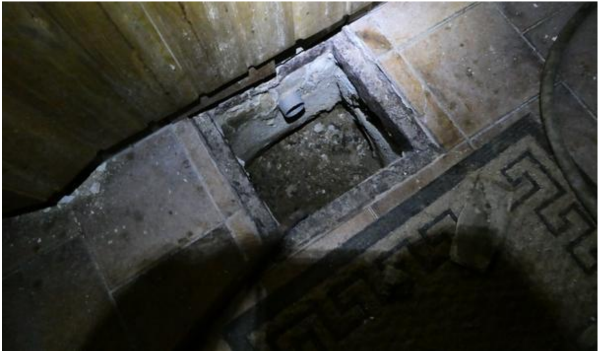
Abbildung 37: Entwässerungsschacht Keller
