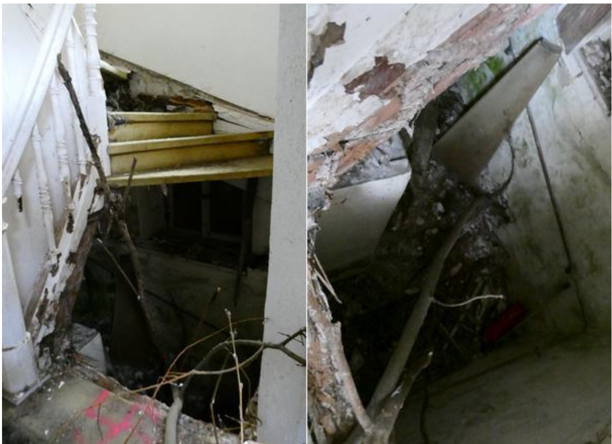
Abbildung 42: Zustand des Treppenhauses (EG zu 1, OG)
