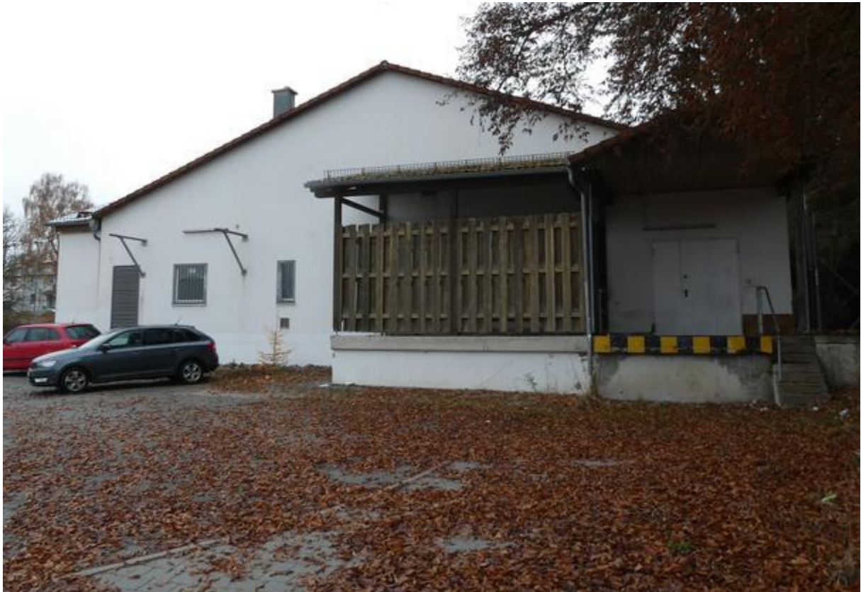
Abbildung 56: Ansicht von der Wunsiedler Straße aus betrachtet
