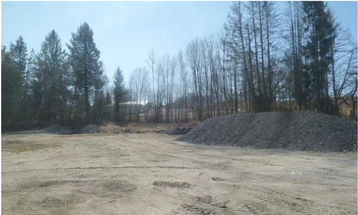
Abbildung 15: Baufeld auf der Fläche der ehem. Pelzfabrik
