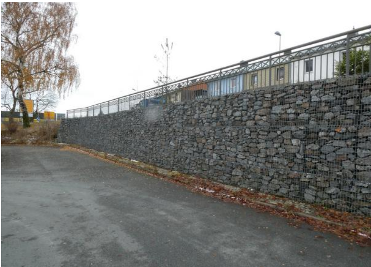
Abbildung 58: Gabionen-Mauer am Südrand zur Bergstraße hin
