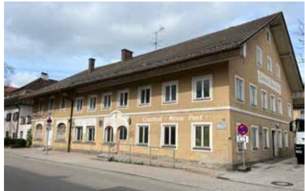
Abb.64: Leerstand Gasthof Neue Post, Salzstraße 12
