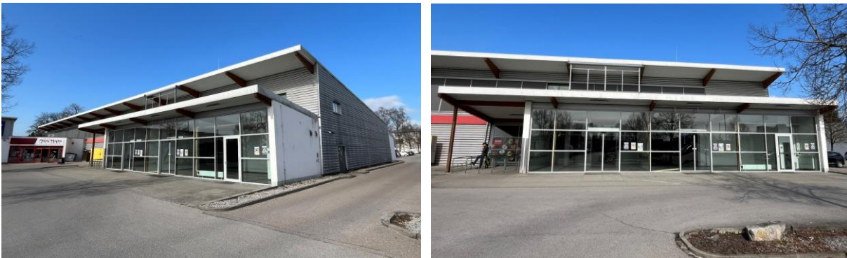
Abbildung 1: Vorhabenstandort an der Hermann-Böcker-Straße
