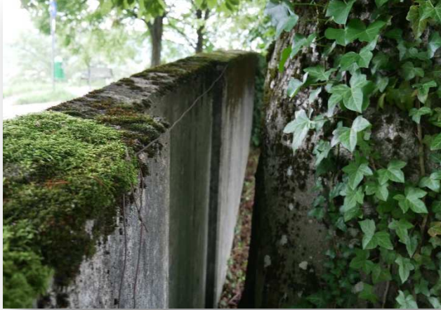
Abb. 34 Grundstücksmauer auf Höhe der Buche
