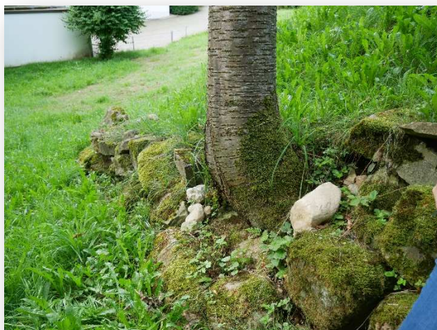
Abb. 18 Säbelwuchs mit fehlenden Stützwurzeln
