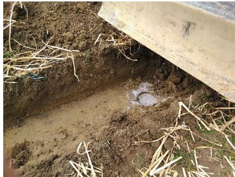
8 SCH 1 Abtrag Oberboden
