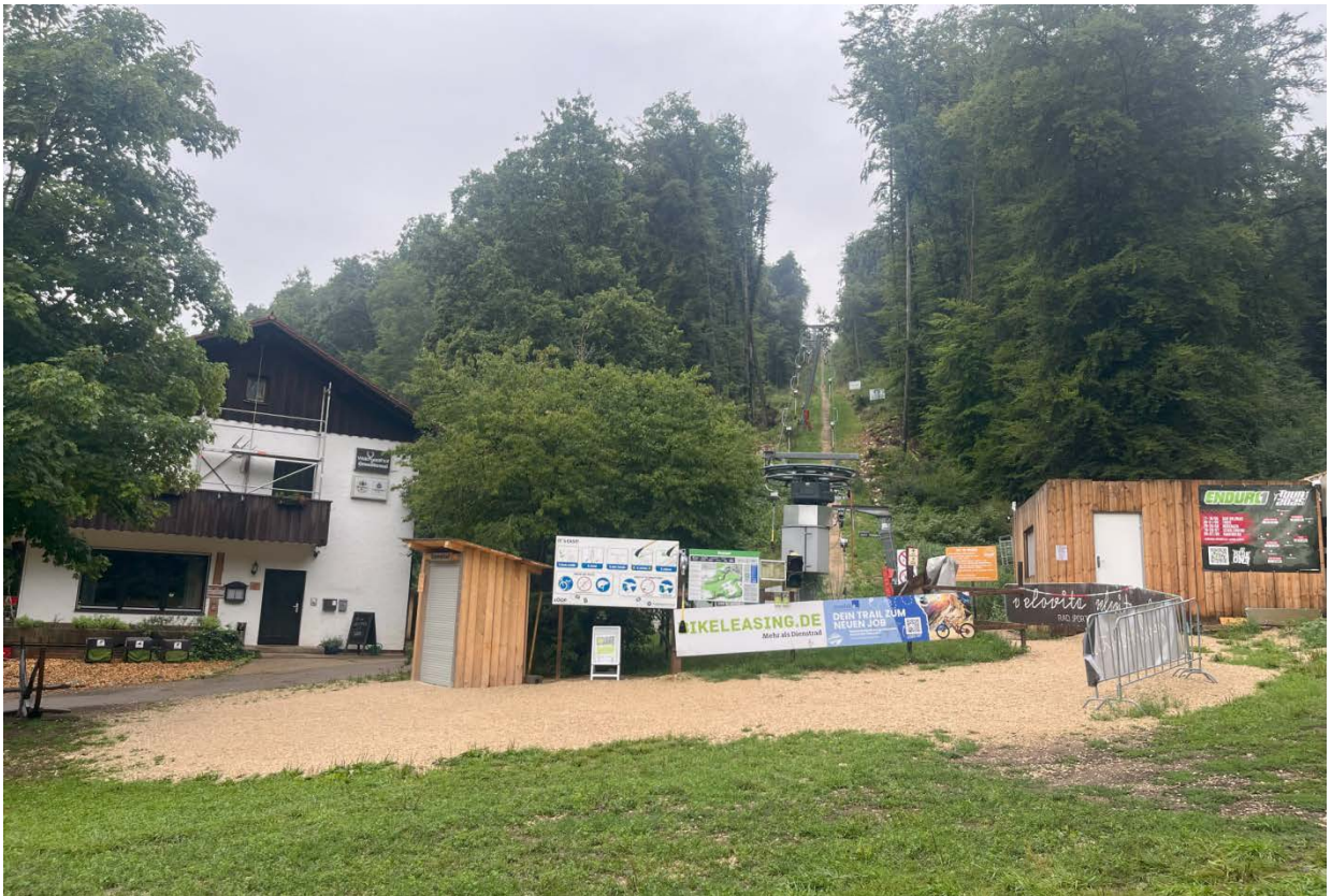
Abbildung 6: Talstation mit Liftanlage und Gaststätte
