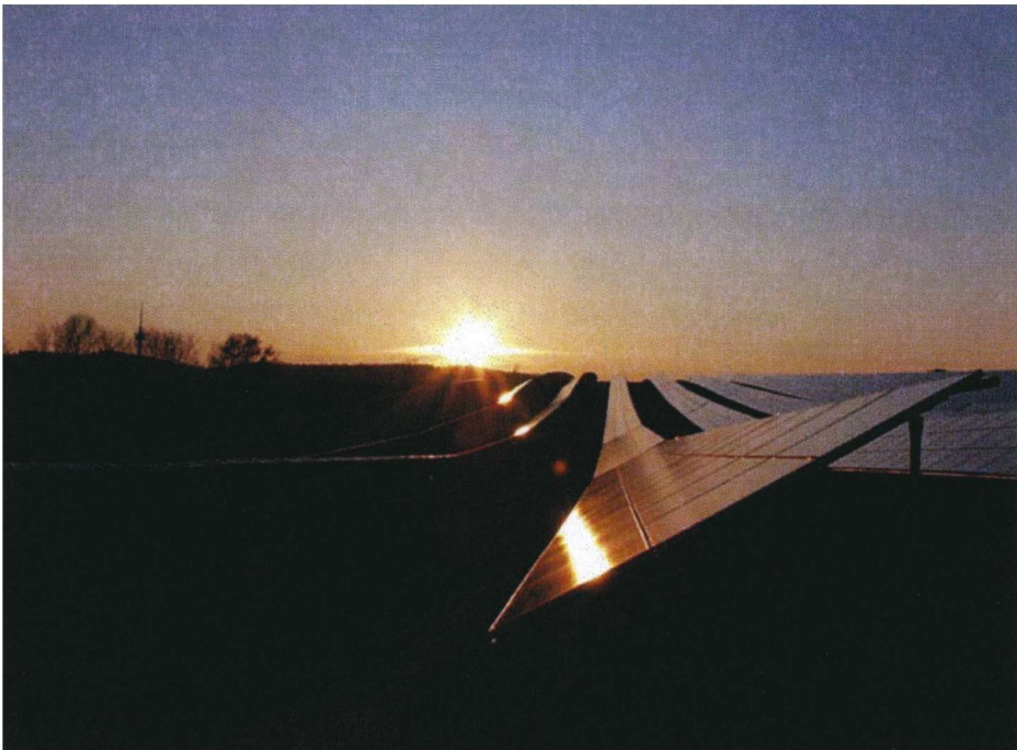
Abb. 3: Blendungssituation bei streifendem Lichteinfall gem. [4]
