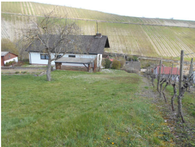
Blick vom Westrand der Fl.Nr. 3888 talwärts in östliche Richtung zum bestehenden Wohnhaus Kapellenstraße 27
