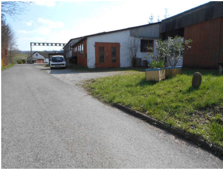
Blick über das Plangebiet von der bestehenden Erschließungsstraße im Norden der Fl.Nr. 3888/1 in südliche Richtung
