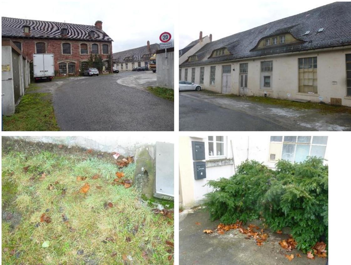
Abb. 8: Eingangsbereich des Hegewaldgeländes mit ehemaliger Lagerhalle und ehemaligem Lagerhaus mit Wohnhaus um Hintergrund. Angrenzende Grünstreifen (G11) und Eibenbüsche (B141)
