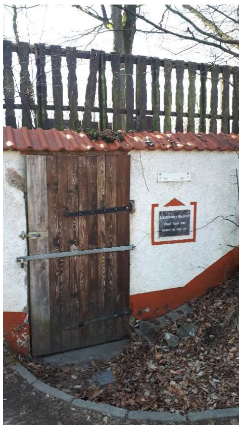
Abb.6: mit Felsenkeller in der westlichen Böschung, 24.03.2022
