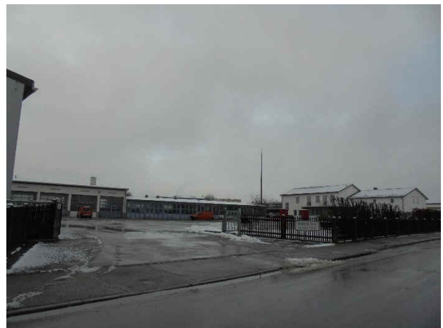
Bild 10: Straßenmeisterei TF01 O-Ansicht
