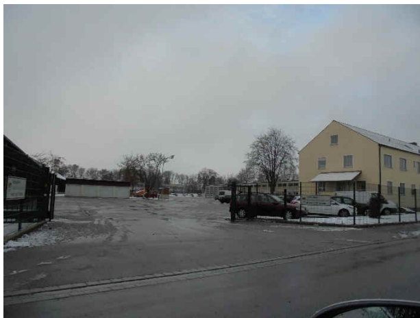
Bild 9: Bauhof Landkreis ND-SOB TF05 O-Ansicht
