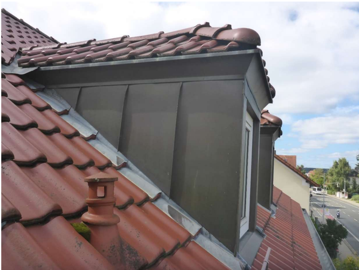
Abbildung 4: Dicht abschließende Gauben und Dachhaut auf der Nordseite des Bürogebäudes (Aufnahme vom 14.09.2023).
