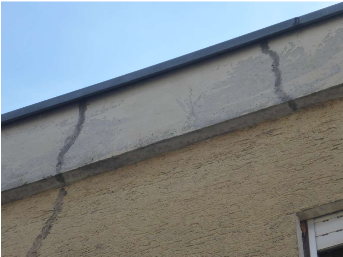
Abbildung 10: Flachdachabschluss des Wohngebäudes mit für Fledermäuse eher ungeeigneter Ausbildung (Aufnahme vom 14.09.2023).
