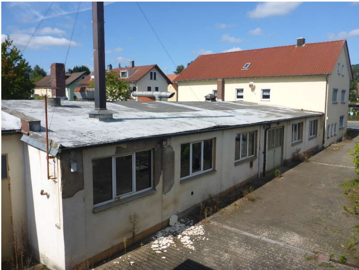
Abbildung 6: Fertigungshalle hinter dem Bürogebäude (Blick von Südosten) (Aufnahme vom 14.09.2023).
