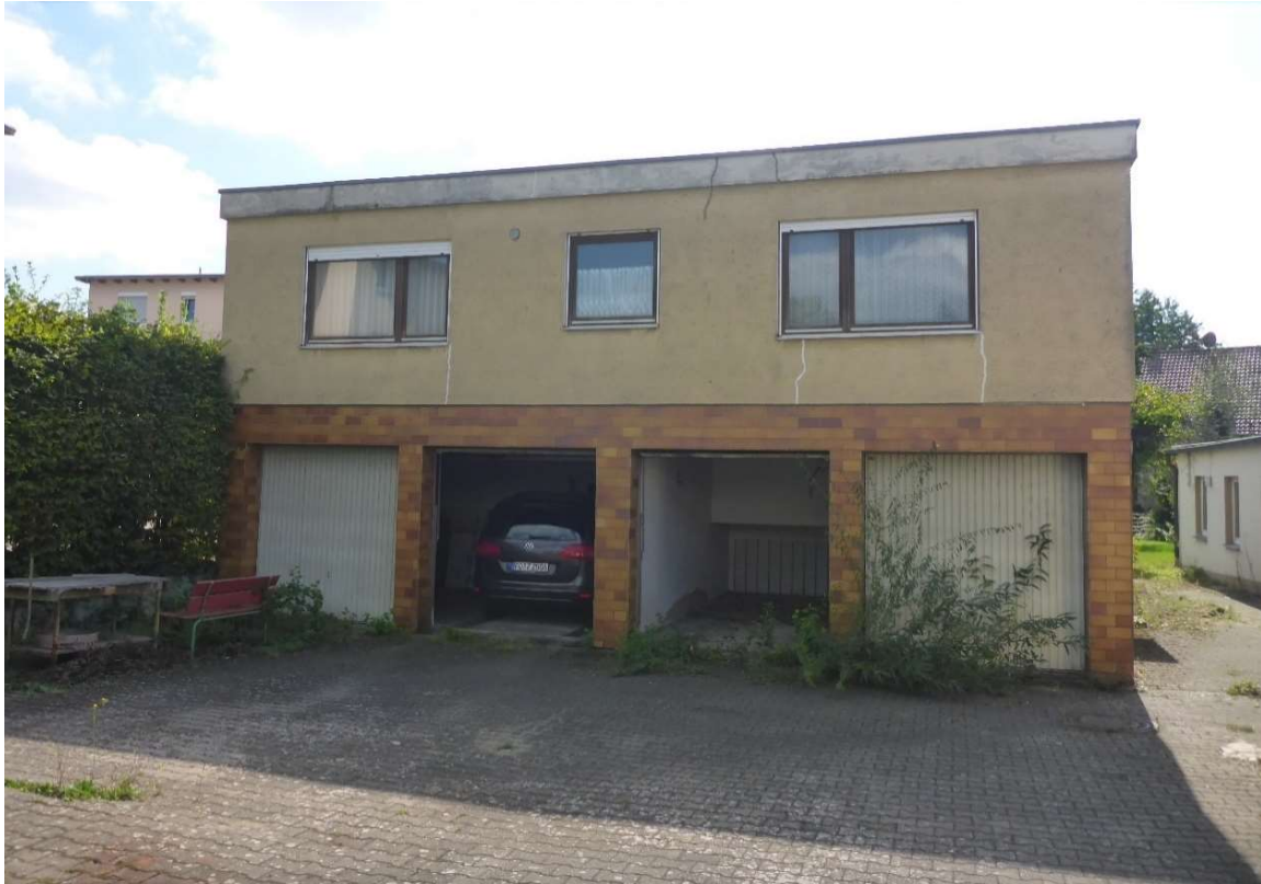
Abbildung 9: Flachdachgebäude östlich neben der Fertigungshalle (Blick von Norden) (Aufnahme vom 14.09.2023).
