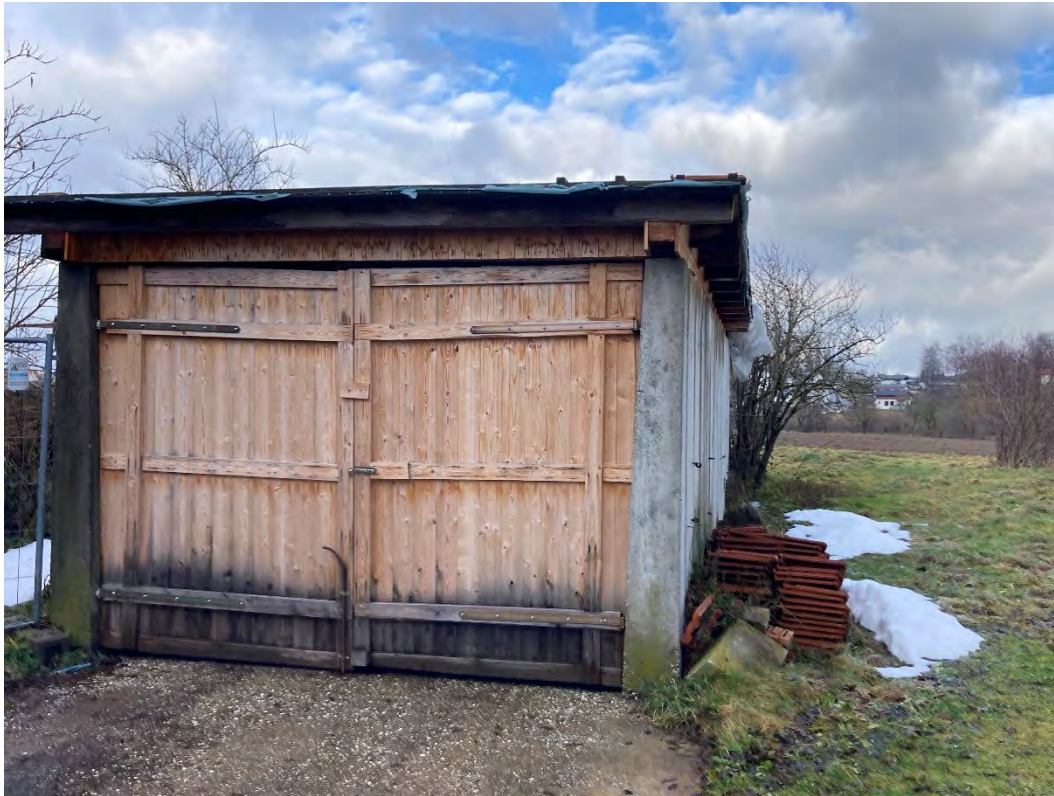
Abbildung 13: Garage westlich des Wohnhauses.
