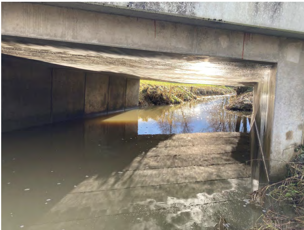
Abbildung 20: Betonbrücke über die Große Vils an der östlichen Grenze des Plangebiets. Die Fugen zwischen den Betonelementen sind nicht tief und nicht als Fledermaus-Hangplätze geeignet.
