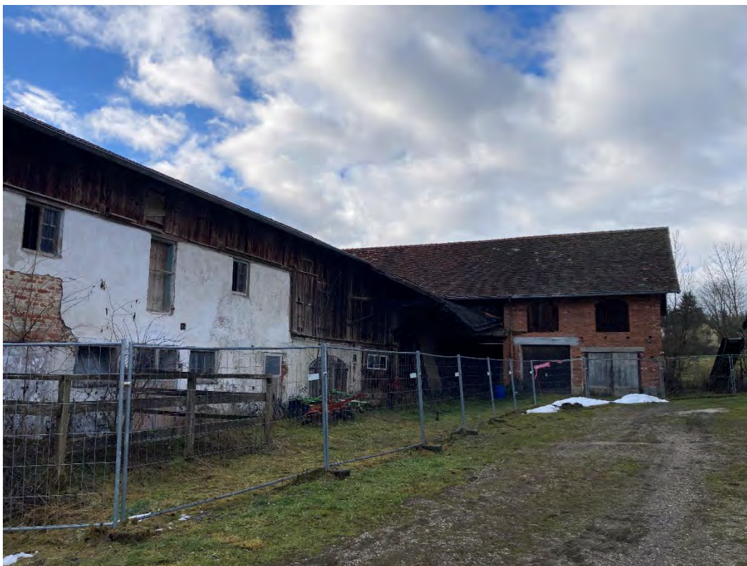
Abbildung 14: Nordfassade des Stallgebäudes (links im Bild) und Ostfassade der Scheune (im Hintergrund).
