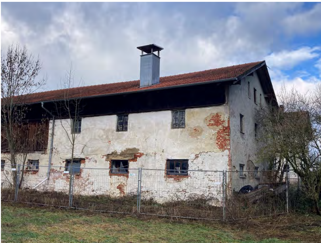
Abbildung 8: Ehemaliges Stallgebäude der Hofstelle im Plangebiet. Blick von Südosten.
