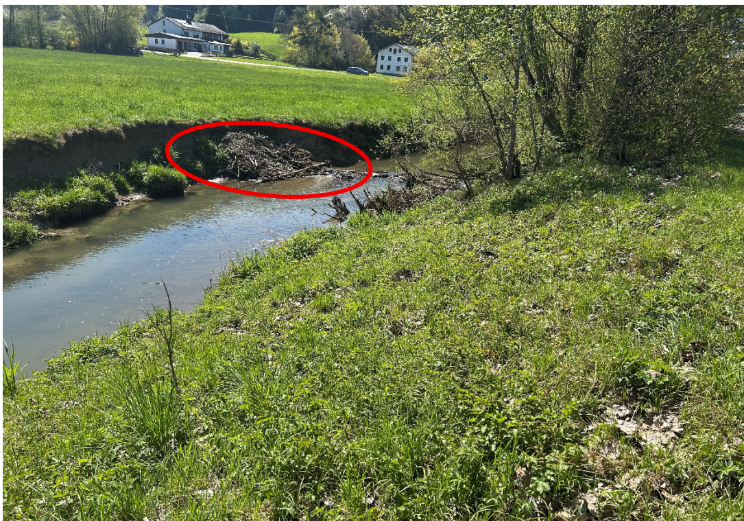
Abbildung 7: Abbruchkante an der Großen Vils im Plangebiet ungeeignet für den Eisvogel. Aktivität des Bibers ( Castor fiber ), rot eingerahmt. Foto: K. Stefferl, April 2026.
