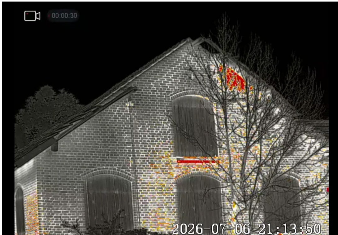
Abbildung 6: Am 06.07.2026 mittels Wärmebildkamera aufgezeichneter Gebäudeausschnitt. (Abbildung dient als Nachweis des Geräteeinsatzes)
