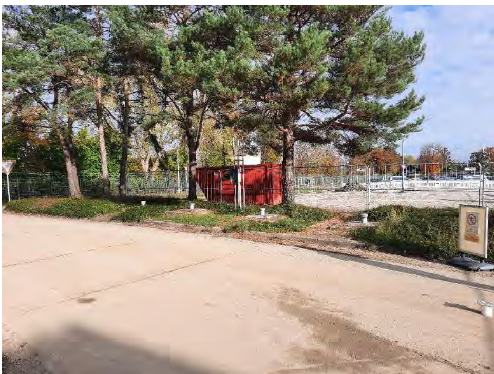
Abbildung 29: Ansicht der Abdeckungen der Tanks (von rechts nach links) III, IV, V und VI. Foto: HYDRODATA GmbH, 29.10.2024
