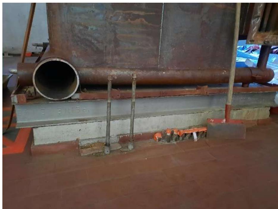
Abbildung 23: Detailaufnahme eines Heizkessels; verschlossene Zu- und Ableitungen für Heizöl. Foto: HYDRODATA GmbH, 29.10.2024
