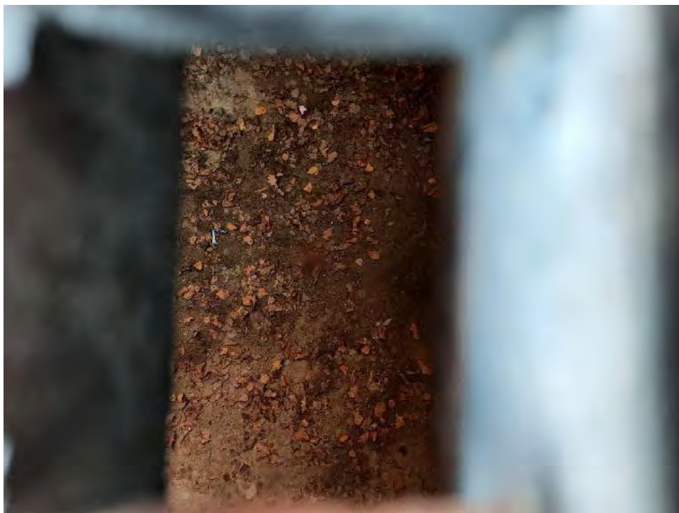
Abbildung 9: Blick durch die Abdeckung auf den Boden der Wartungsgrube. Foto: HYDRODATA GmbH, 29.10.2024
