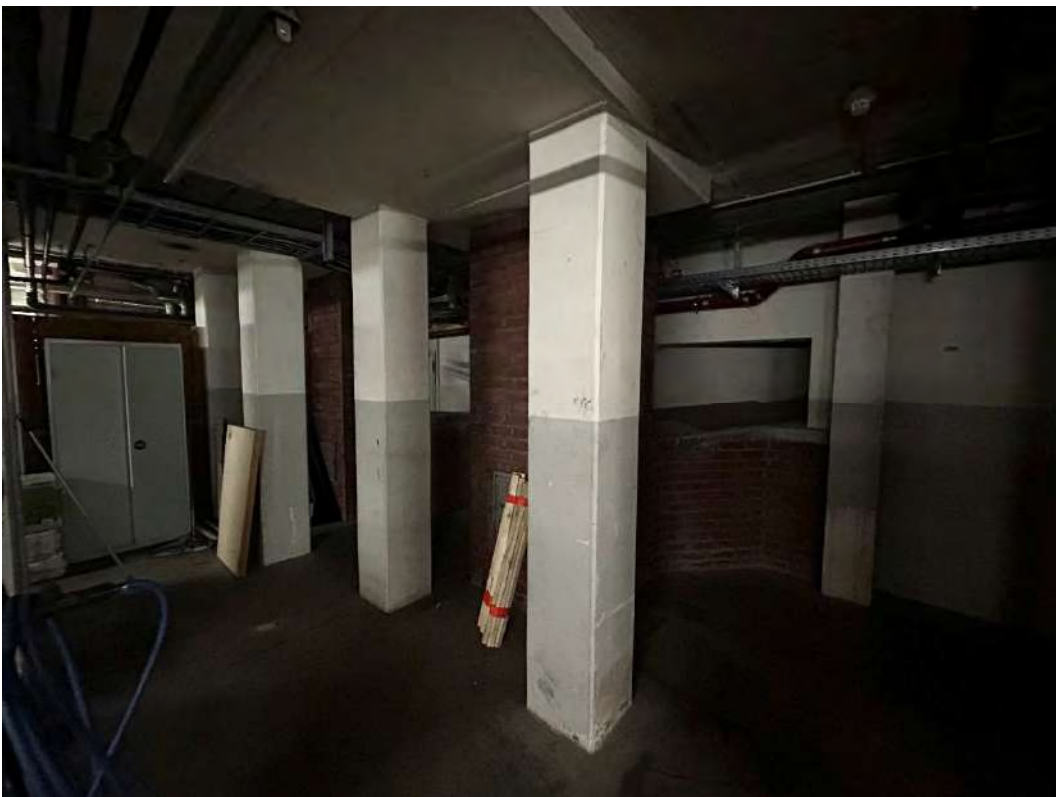
Abb. 29: KVF Nr. 07 – Stillgelegter Heizraum Kellerraum unterhalb der Heizkessel. Blick nach Westen. Foto: Edgar Geyer (DLR), 19.12.2024
