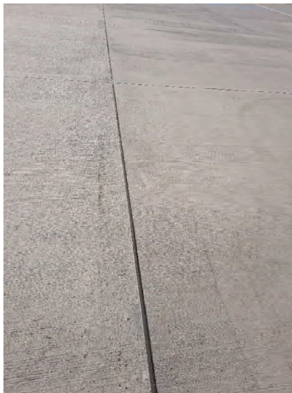
Abb. 52: KVF Nr. 16 – Manipulationsfläche vor Flughalle 160 Bodenversiegelung im Bereich der Manipulationsfläche. Foto: Hydrodata GmbH, 29.10.2024
