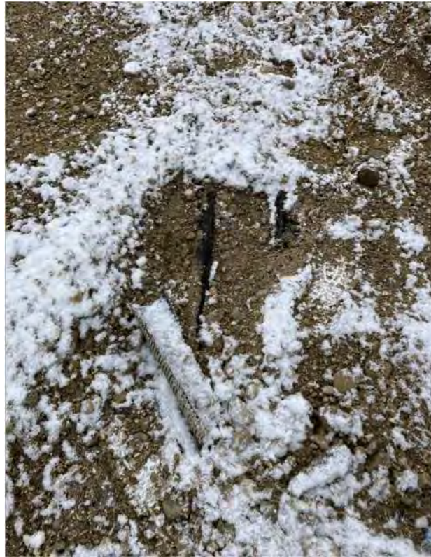
Abb. 68: KVF Nr. 21 – Kraftstoffleitung unter Parkplatz P172 Zwei parallel verlaufende Leitungen noch im Boden. Die schwarze Ummantelung ist gut zu erkennen. Foto: Clemens Rausch (DLR), 18.02.2025
