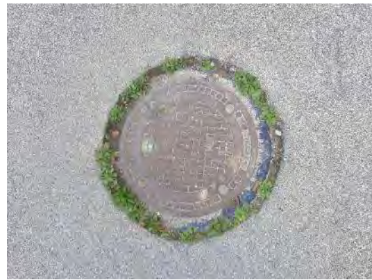
Abb. 1: KVF Nr. 01 – Fettabscheider vor Geb. 102 Deckel des neuen Fettabscheiders. Blick nach NNW. Foto: Hydrodata GmbH, 29.10.2024
