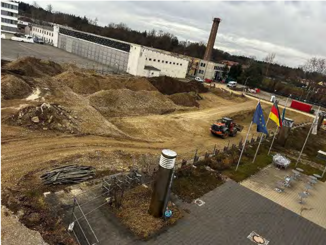
Abb. 97: KVF Nr. 30 – Bereich zwischen Gebn. 110, 122 und P172 Die Baugrube von oben gesehen mit Blick nach Westen. Foto: Edgar Geyer (DLR), 19.12.2024
