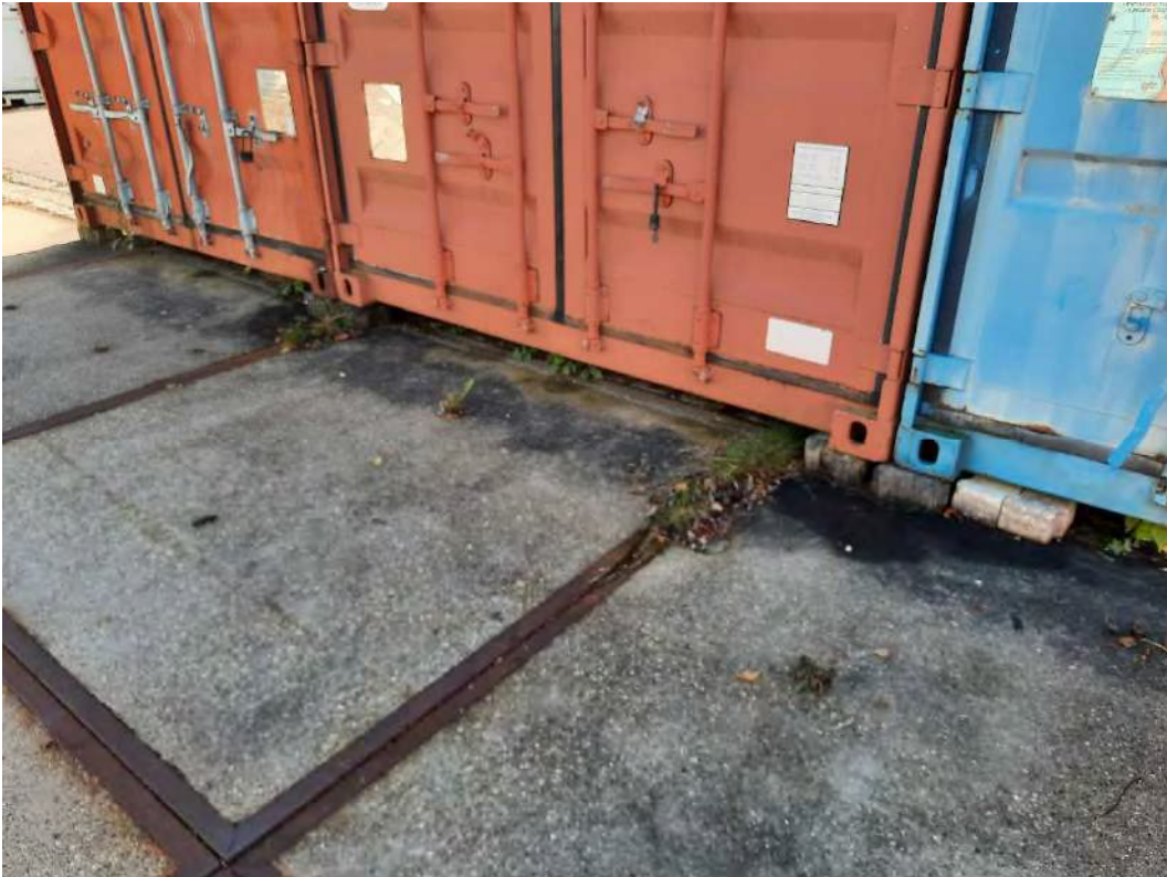
Abb. 62: KVF Nr. 19 – Containerstellfläche Stahlumrahmte Betonplatten als Bodenversiegelung auf der Stellfläche. Foto: Hydrodata GmbH, 29.10.2024
