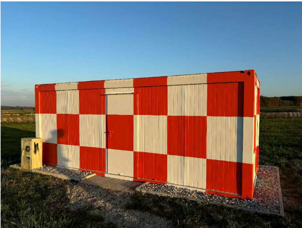
Abb. 101:KVF Nr. 32 – Wiese, Flurstück 828 Kontrollcontainer für die Funkleitfeuerung. Blick nach Osten Foto: Hydrodata GmbH, 29.10.2024
