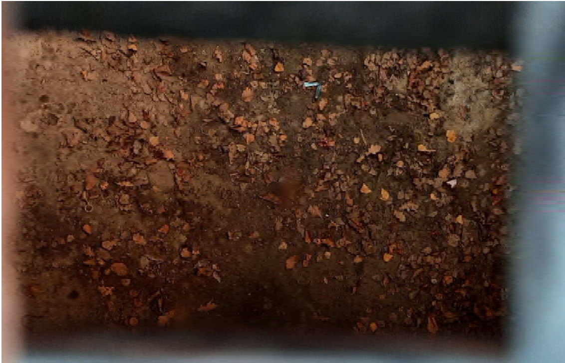
Abb. 3: KVF Nr. 02 – PKW-Garage mit Wartungsgrube Blick in die Wartungsgrube. Foto: Hydrodata GmbH, 29.10.2024
