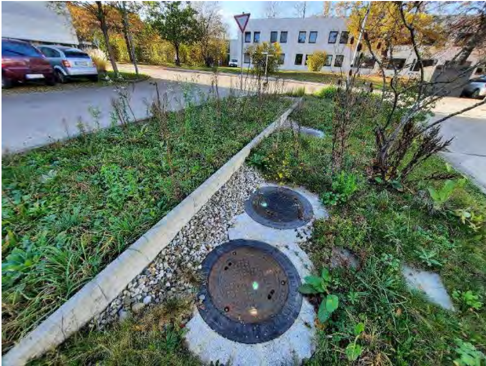
Abbildung 6: Abdeckungen des neuen Fettabscheiders. Foto: HYDRODATA GmbH, 29.10.2024
