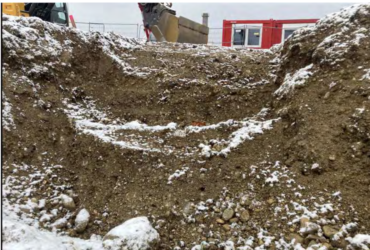
Abb. 70: KVF Nr. 21 – Kraftstoffleitung unter Parkplatz P172 Ende der Leitungen. Blick nach Osten. Foto: Clemens Rausch (DLR), 18.02.2025
