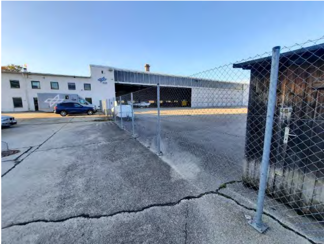
Abb. 18: KVF Nr. 06 – Flugzeughalle und zugehöriges Vorfeld Blick nach Nordwesten auf die geöffnete Halle. Foto: Hydrodata GmbH, 29.10.2024
