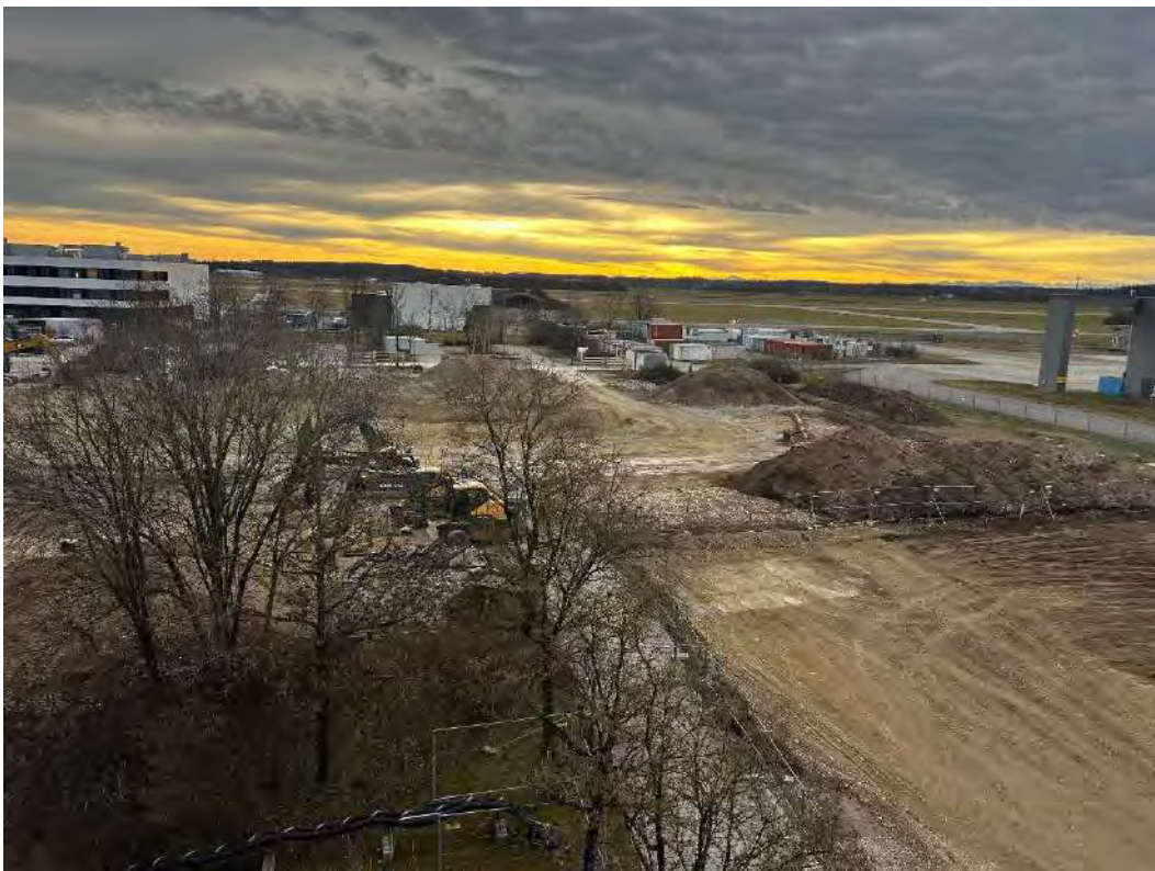
Abb. 67: KVF Nr. 20 – Parkplatz P172 Der aktuelle Zustand des Rückbaus des Parkplatzes. Foto: Edgar Geyer (DLR), 19.12.2024
