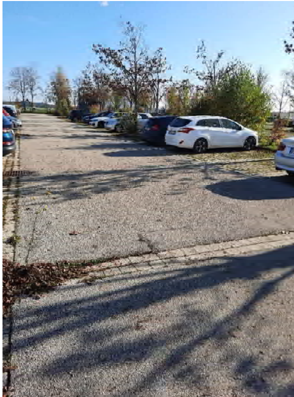
Abb. 66: KVF Nr. 20 – Parkplatz P172 Bodenversiegelung im Bereich der Fahrflächen. Blick nach Nordwesten. Foto: Hydrodata GmbH, 29.10.2024
