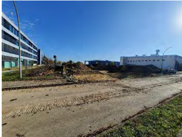
Abbildung 75: Die Baustelle zur Zeit der Ortsbegehung, Blickrichtung nach Südosten. Foto: HYDRODATA GmbH, 29.10.2024
