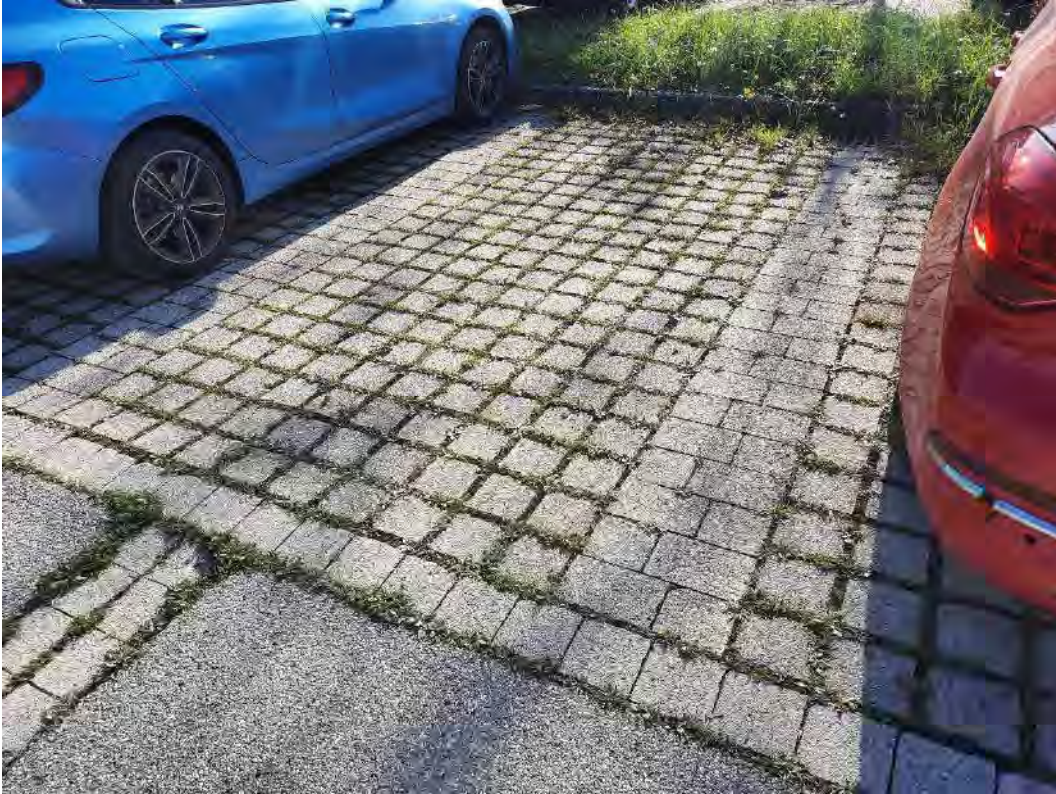
Abb. 64: KVF Nr. 20 – Parkplatz P172 Bodenbefestigung im Bereich der Parkflächen. Foto: Hydrodata GmbH, 29.10.2024
