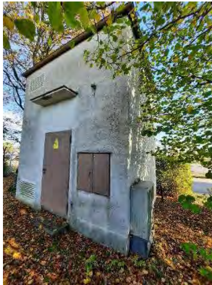
Abbildung 58: Trafohaus in der Nähe von Parkplatz P174 Foto: HYDRODATA GmbH, 29.10.2024
