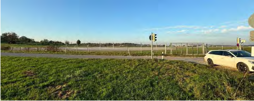
Abb. 98: KVF Nr. 31 – Südlicher Teil der Start- und Landebahn, Flurstück 1048 Blick auf die Landebahn direkt an der Gautinger Str. Blick nach Norden. Foto: Hydrodata GmbH, 29.10.2024
