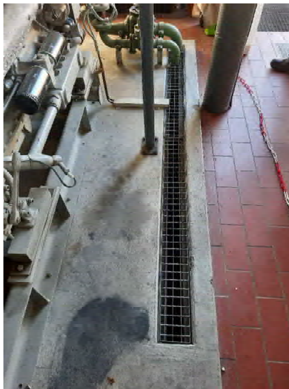
Abb. 33: KVF Nr. 08 – Notstromaggregat Ablaufgitter und Bodenversiegelung am Aggregat, nordöstliche Ecke. Foto: Hydrodata GmbH, 29.10.2024
