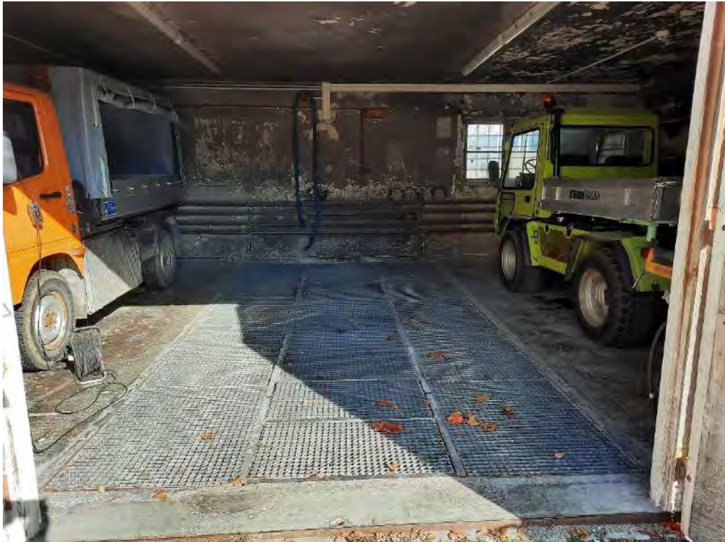
Abbildung 8: Garage mit ehemaliger Wartungsgrube unterhalb des Gitters. Foto: HYDRODATA GmbH, 29.10.2024
