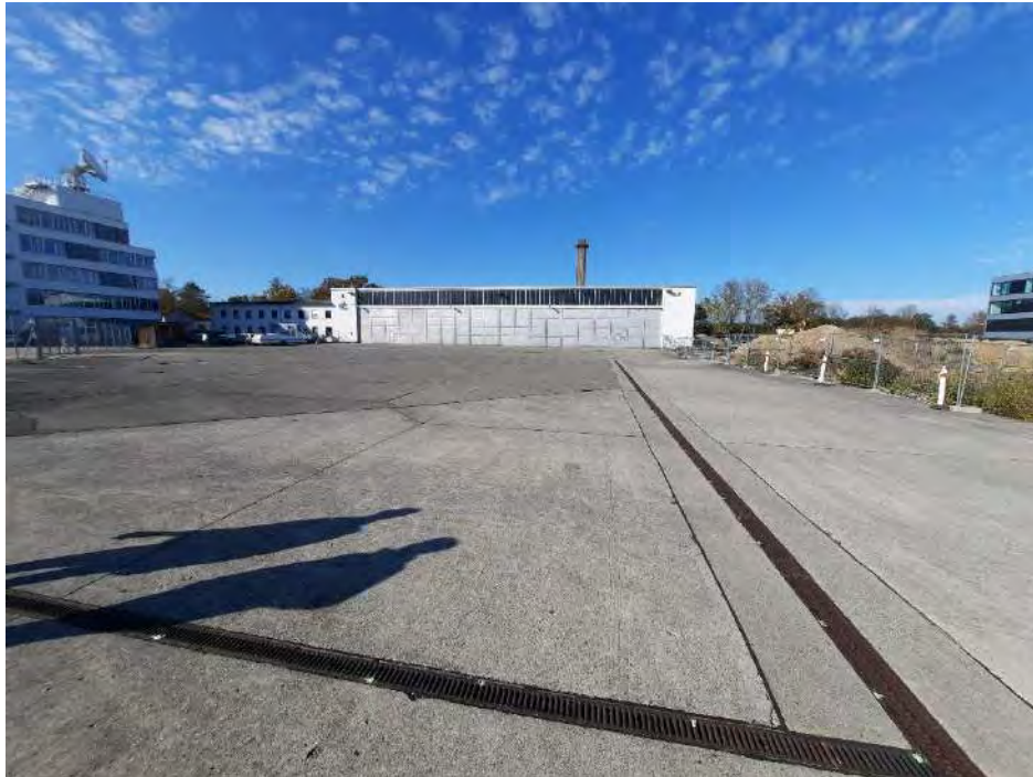
Abbildung 20: Aktueller Zustand der Flugzeughalle Gebäude 110. Foto: HYDRODATA GmbH, 29.10.2024
