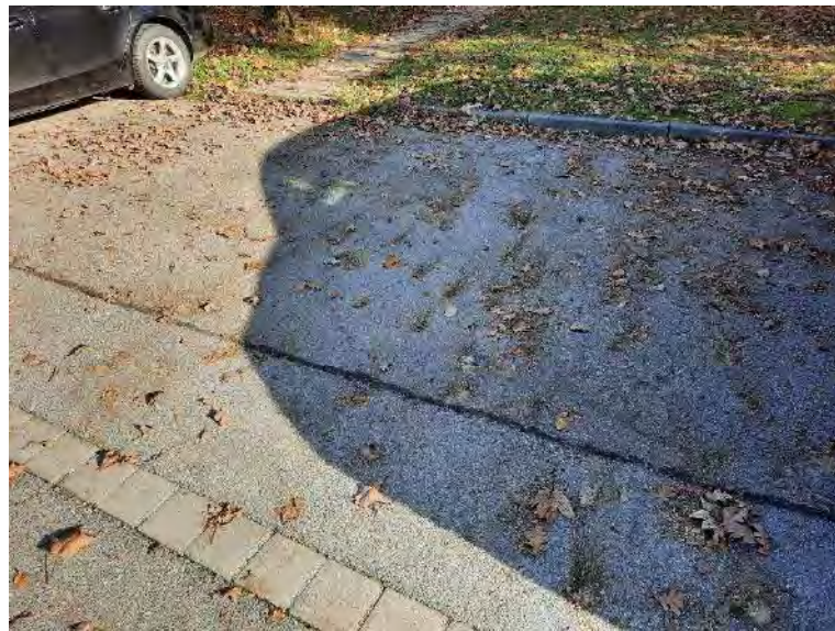
Abbildung 66: Oberflächenversiegelung auf Parkplatz P177. Foto: HYDRODATA GmbH, 29.10.2024
