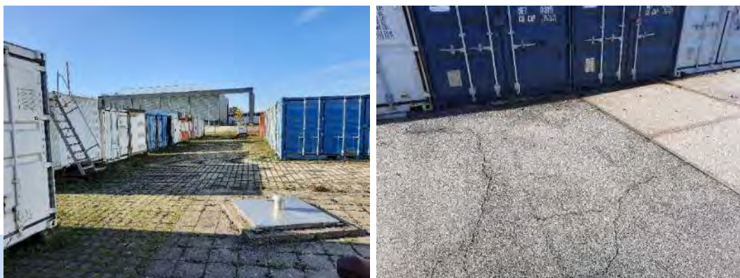
Abbildung 50: Oberflächenversiegelungen im Bereich des Containerstellplatzes. Links: Betonpflaster, Rechts: Asphalt und stahlumrahmte Betonplatten. Foto: HYDRODATA GmbH, 29.10.2024
