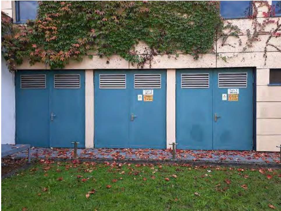
Abbildung 31: Ansicht Traforäume von außen. Foto: HYDRODATA GmbH, 29.10.2024
