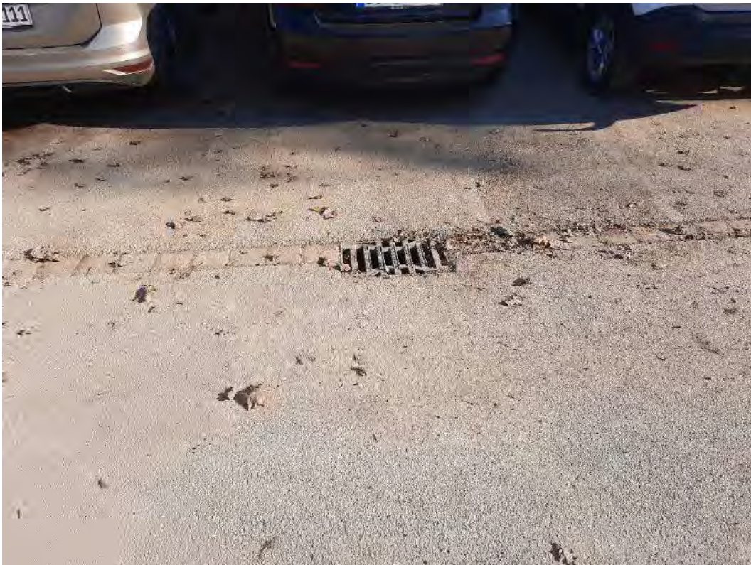
Abb. 78: KVF Nr. 25 – Parkplatz P176 Sickerkasten am Parkplatz P176. Foto: Hydrodata GmbH, 29.10.2024
