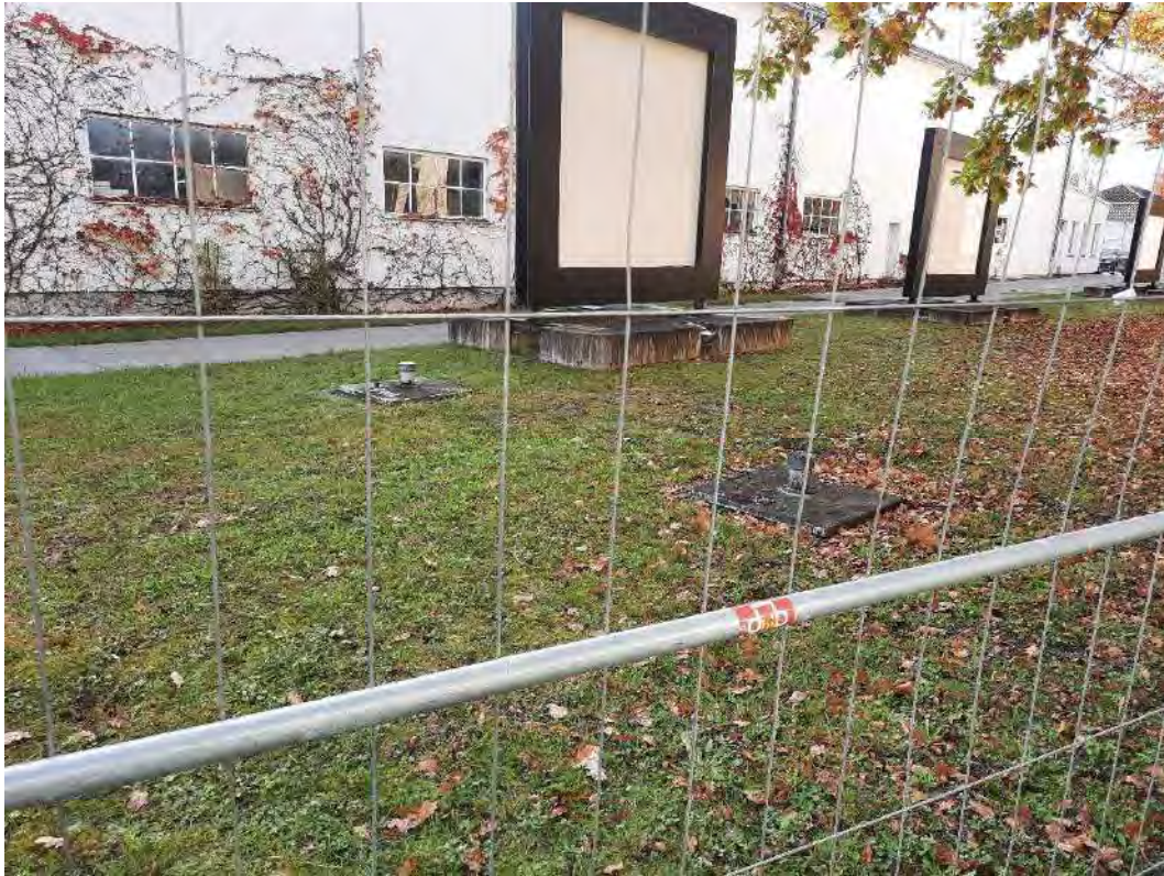
Abb. 36: KVF Nr. 09 – Öltanks Die stillgelegten Öltanks I und II. Blick nach Süden. Foto: Hydrodata GmbH, 29.10.2024
