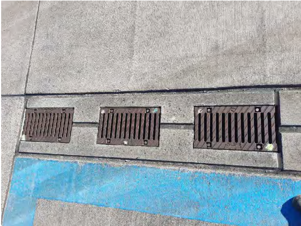
Abb. 53: KVF Nr. 16 – Manipulationsfläche vor Flughalle 160 Nördliches Ende der Abflusrinne. Foto: Hydrodata GmbH, 29.10.2024
