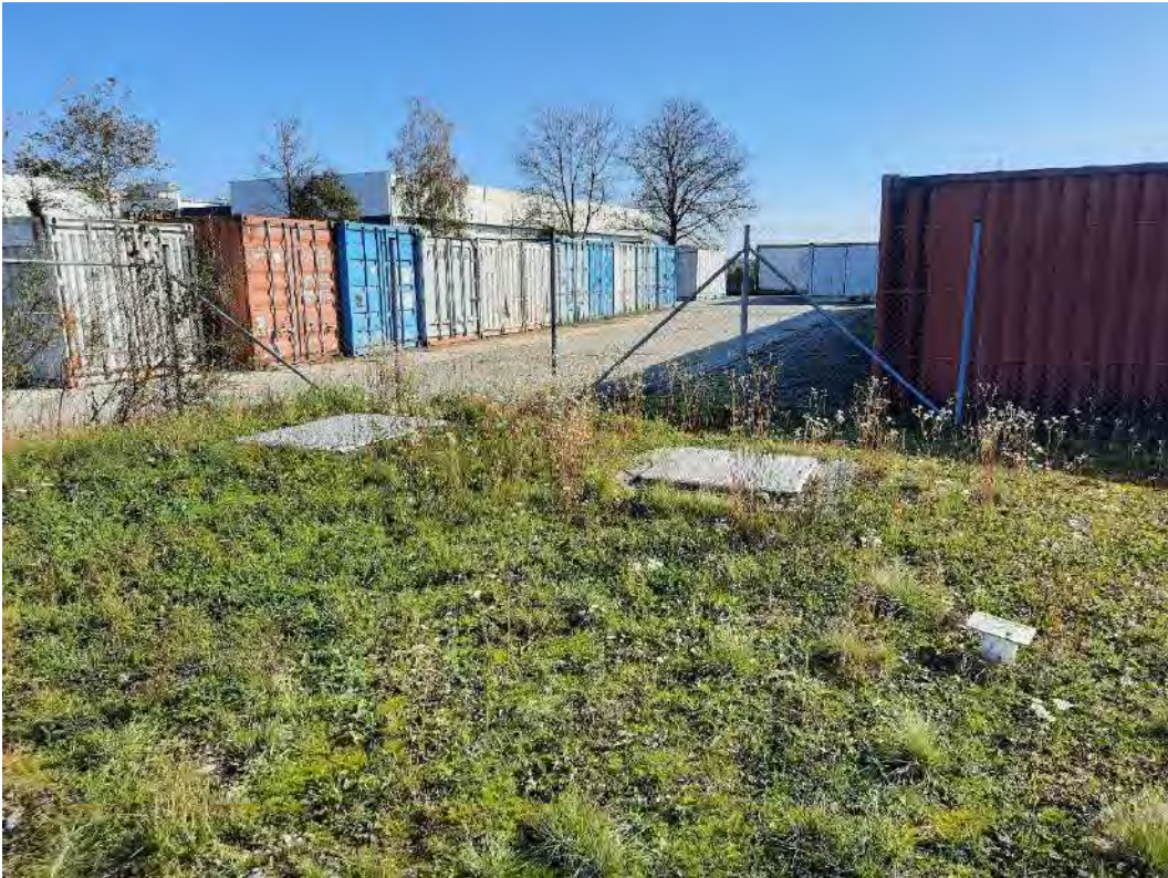
Abb. 55: KVF Nr. 17 – Abscheider bei Manipulationsfläche Abdeckungen des Regenrückhaltetanks. Foto: Hydrodata GmbH, 29.10.2024
