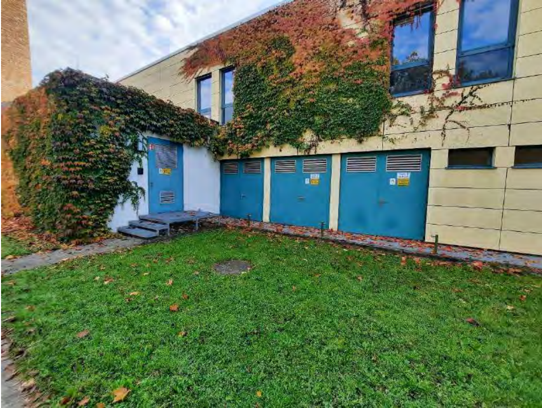
Abb. 41: KVF Nr. 10 – Trafostation Gebäude 113 Blick nach Osten auf die Außenseite der Traforäume. Foto: Hydrodata GmbH, 29.10.2024
