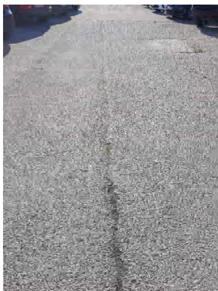
Abb. 71: KVF Nr. 22 – Parkplatz P174 Auswahl an Rissen in der Asphaltdecke. Foto: Hydrodata GmbH, 29.10.2024
