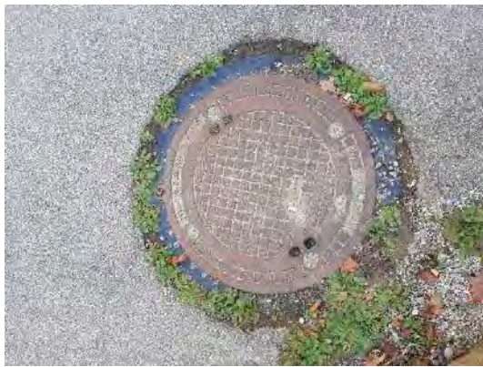
Abb. 2: KVF Nr. 01 – Fettabscheider vor Geb. 102 Deckel des stillgelegten Fettabscheiders. Foto: Hydrodata GmbH, 04.07.2024
