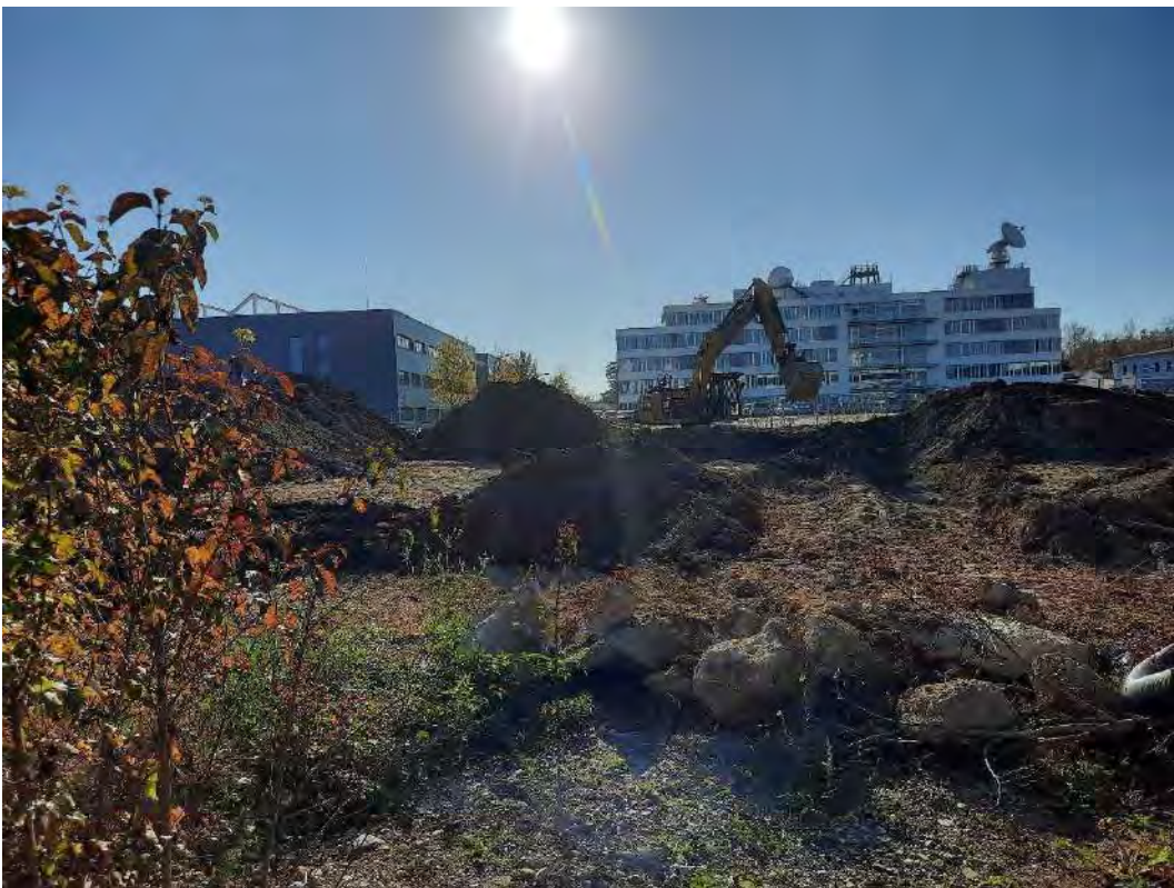
Abb. 96: KVF Nr. 30 – Bereich zwischen Gebn. 110, 122 und P172 Bagger in der Baugrube. Blick nach Südwesten auf Geb. 103 (links) und 160 (rechts). Foto: Hydrodata GmbH, 29.10.2024
