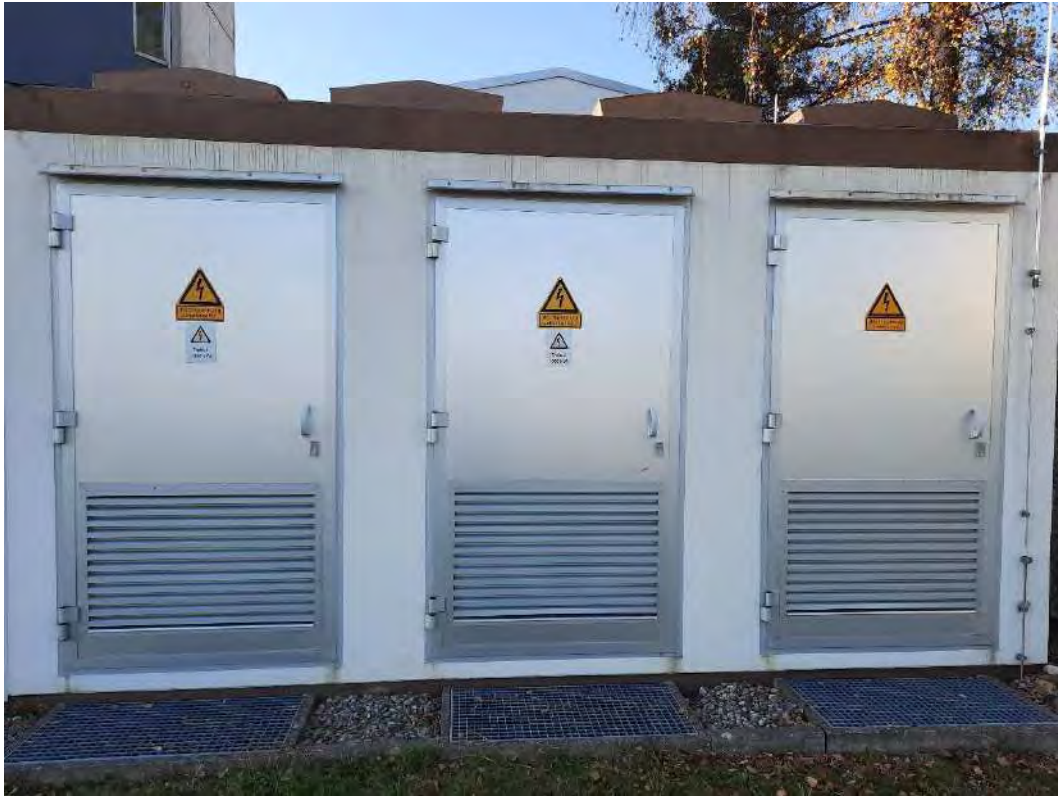
Abb. 49: KVF Nr. 14 – Trafogebäude 151 Eingänge zu den Trafogebäuden. Foto: Hydrodata GmbH, 29.10.2024
