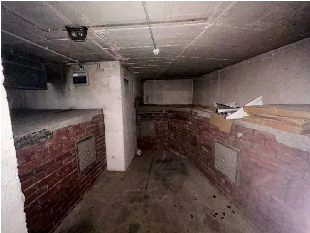
Abb. 28: KVF Nr. 07 – Stillgelegter Heizraum Abluftzuleitungen zum Kamin. Blick nach Nordwesten. Foto: Edgar Geyer (DLR), 19.12.2024
