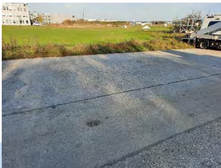
Abbildung 68: Oberflächenversiegelung auf Parkplatz P179. Foto: HYDRODATA GmbH, 29.10.2024
