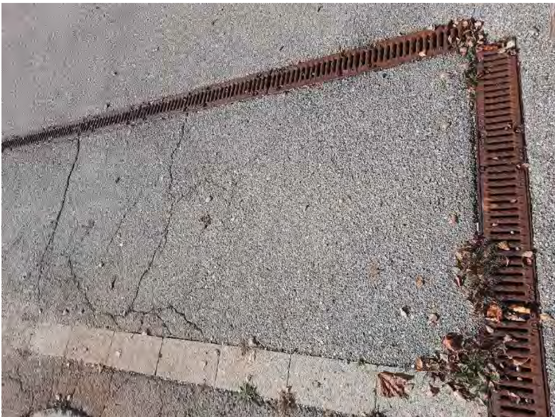
Abb. 8: KVF Nr. 03 – KFZ-Waschplatz mit Ölabscheider Blick auf das Abflussgitter. Die dargestellte Ecke zeigt zur mittleren der drei Garagen. Foto: Hydrodata GmbH, 29.10.2024
