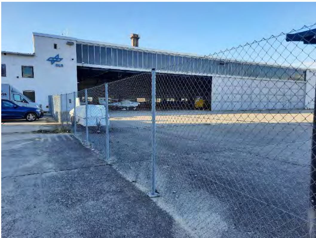
Abb. 19: KVF Nr. 06 – Flugzeughalle und zugehöriges Vorfeld Selber Blick wie Abb. 18, aber etwas näher dran. Foto: Hydrodata GmbH, 29.10.2024
