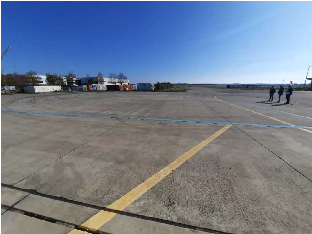
Abb. 51: KVF Nr. 16 – Manipulationsfläche vor Flughalle 160 Die Manipulationsfläche, Blick nach Osten. Foto: Hydrodata GmbH, 29.10.2024
