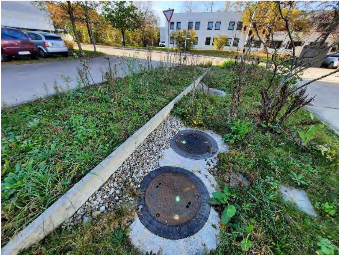
Abb. 1: KVF Nr. 01 – Fettabscheider vor Geb. 102 Deckel des neuen Fettabscheiders. Blick nach NNW. Foto: Hydrodata GmbH, 29.10.2024
