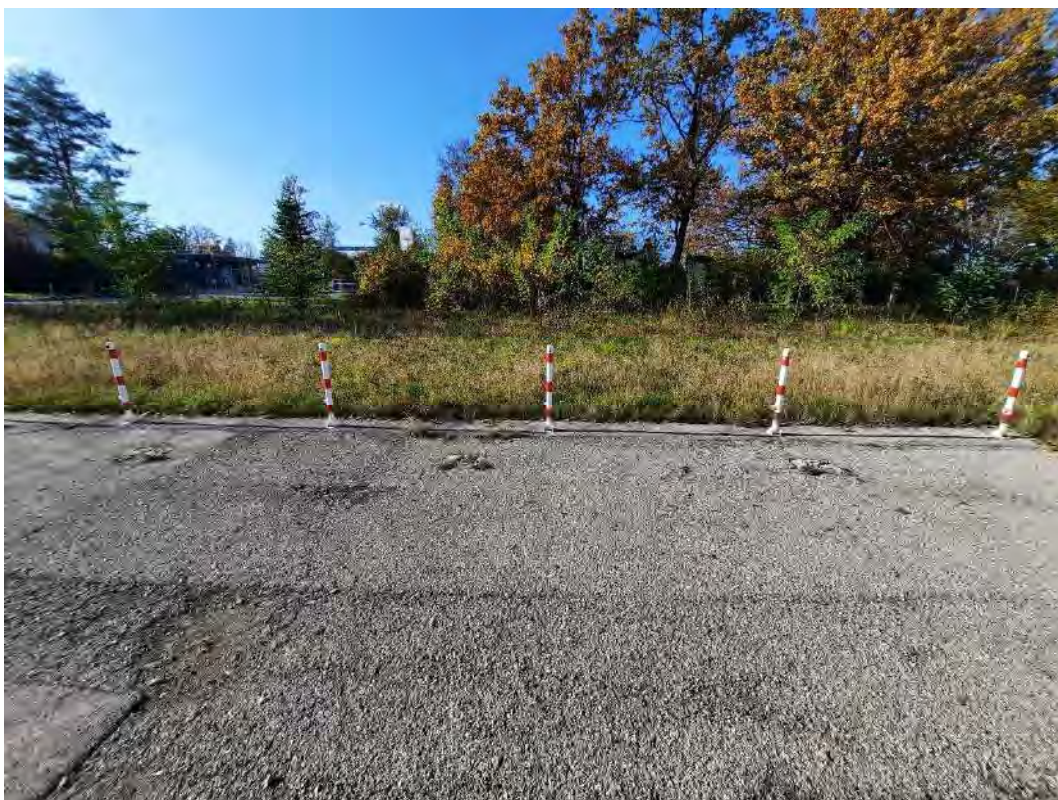
Abb. 10: KVF Nr. 04 – Abgerissene Fahrbereitschaft Blick nach Westen auf den südlichen Teil der abgerissenen Fahrbereitschaft. Foto: Hydrodata GmbH, 29.10.2024
