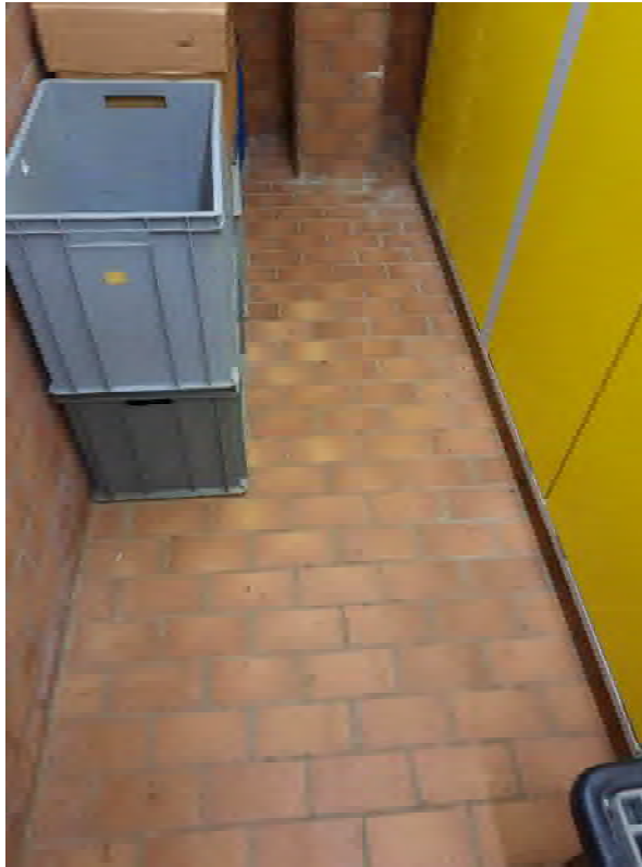
Abb. 42: KVF Nr. 13 – Schadstofflager Gebäude 113 Bodenversiegelung des Schadstofflagers. Foto: Hydrodata GmbH, 29.10.2024
