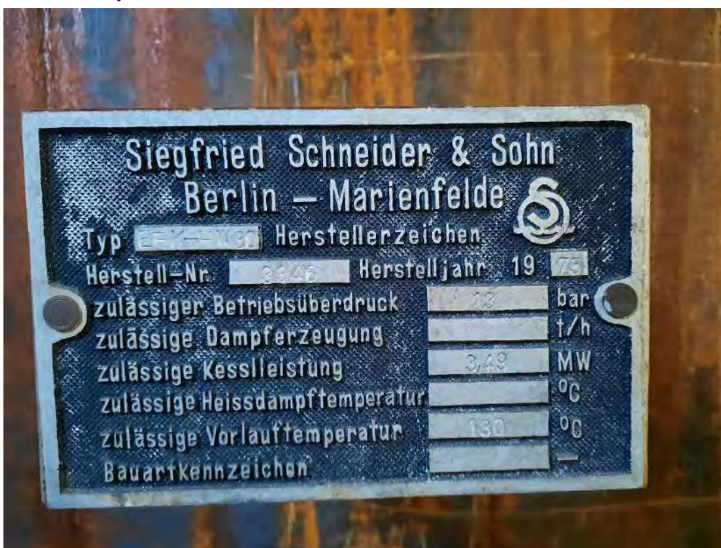
Abb. 25: KVF Nr. 07 – Stillgelegter Heizraum Typenschild eines Heizkessels. Foto: Hydrodata GmbH, 29.10.2024
