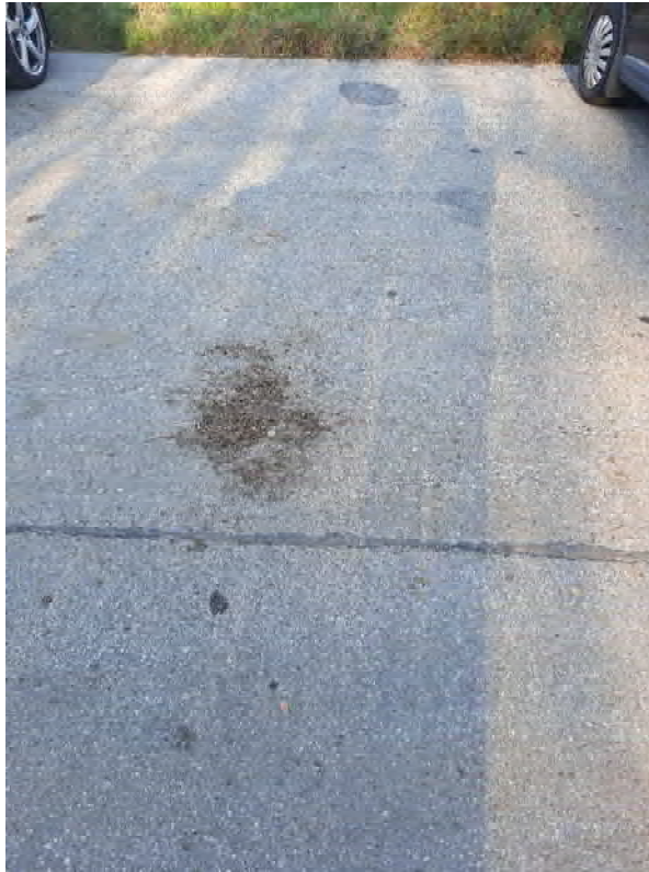
Abb. 90: KVF Nr. 28 – Parkplatz P179 Detail Bodenversiegelung Parkplatz P179. Foto: Hydrodata GmbH, 29.10.2024
