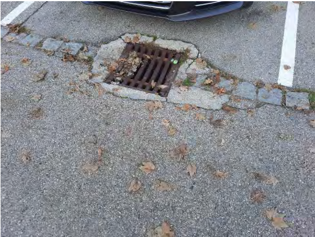
Abb. 74: KVF Nr. 24 – Parkplatz P175 Sickerkasten auf dem Parkplatz P175. Foto: Hydrodata GmbH, 29.10.2024
