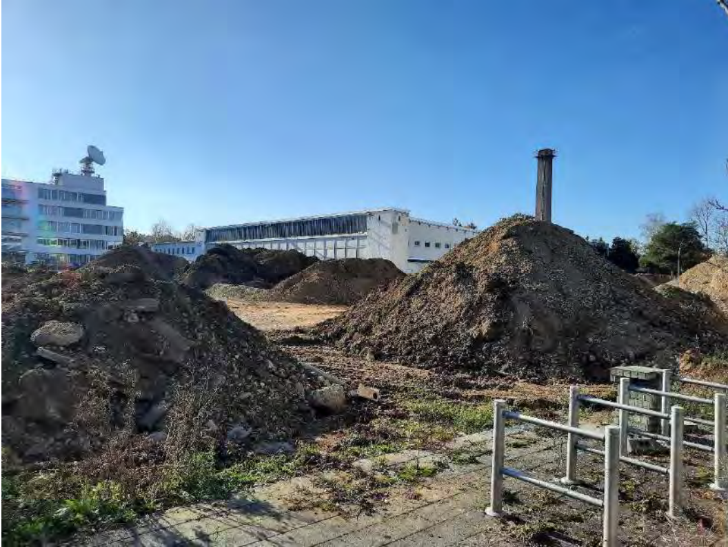
Abb. 95: KVF Nr. 30 – Bereich zwischen Gebn. 110, 122 und P172 Haufen mit sortiertem Aushub aus der Baugrube. Blick nach Westen auf Geb. 110. Foto: Hydrodata GmbH, 29.10.2024
