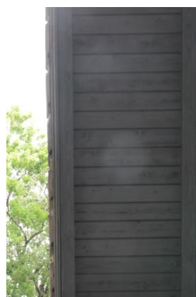
Abb. 5: Die Ortgangbretter weisen keine, für Fledermäuse nutzbaren Spalten auf.
