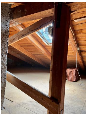
Abb. 14: Übersicht Dachboden des Gebäudes Langenfeldstr. 3.
