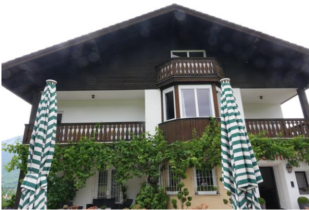
Abb. 2: Südansicht des Gebäudes.
