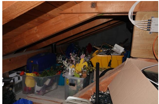
Abb. 9: Ausschnitt des Dachbodens.
