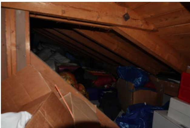
Abb. 8: Ausschnitt des Dachbodens.
