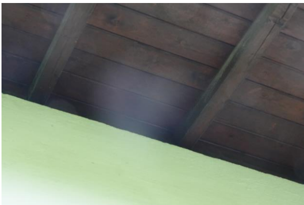
Abb. 12: Die Übergänge Außenmauer und Dachkonstruktion sind geschlossen und verfügen über kein Quartierpotenzial.
