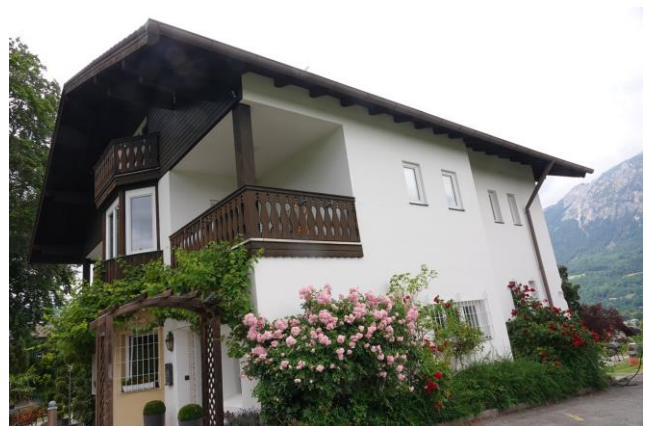
Abb. 3: Ostansicht des Gebäudes.
