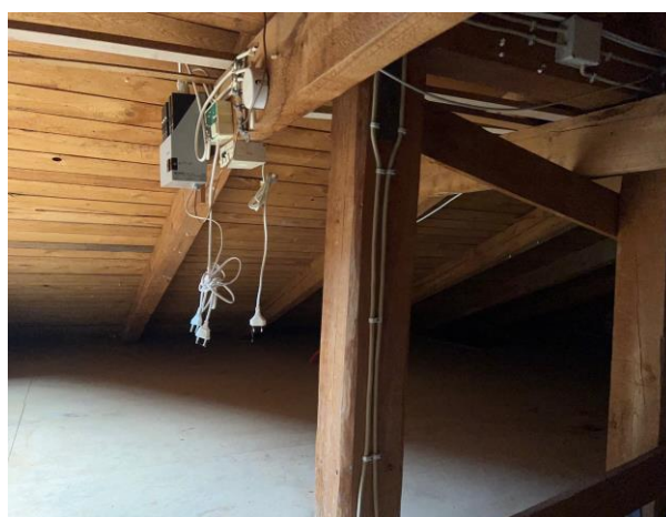
Abb. 15: Übersicht Dachboden des Gebäudes Langenfeldstr. 3.
