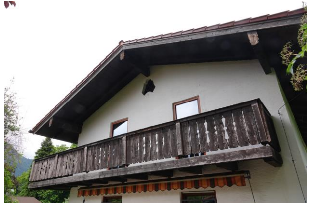
Abb. 11: Westansicht des Gebäudes.
