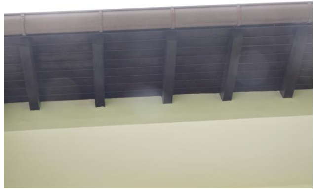
Abb. 7: Die Übergänge Außenmauer und Dachkonstruktion sind geschlossen und verfügen über kein Quartierpotenzial.
