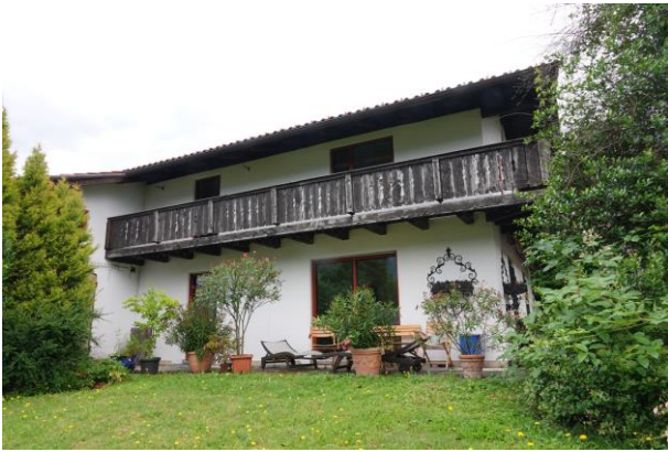
Abb. 10: Nordansicht des Gebäudes Langenfeldstr. 3.
