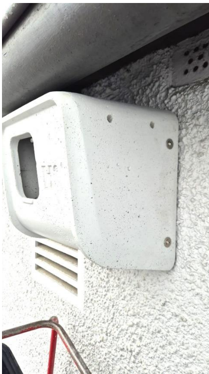
seitliche Lüftungslöcher, jew. zwei auf jeder Seite
