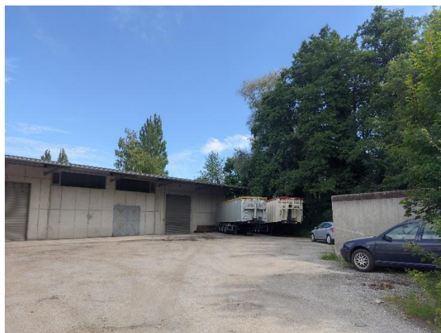
Abb. 4: Lagerhalle auf Fl.Nr. 618, Blick nach Südost Richtung Vils
