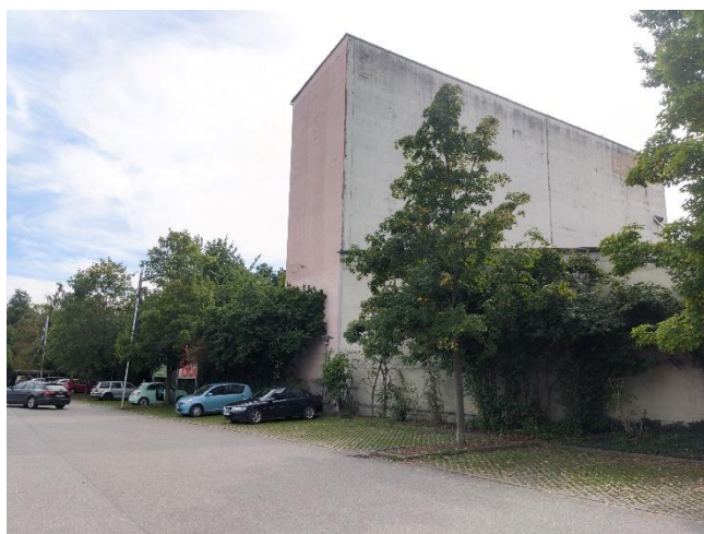
Abb. 5: Parkplatz östl. Fl.Nr. 616 und Hochsilo, Blick nach Südwest, der Hochsilo wurde bereits im Winter 2025/26 abgebrochen
