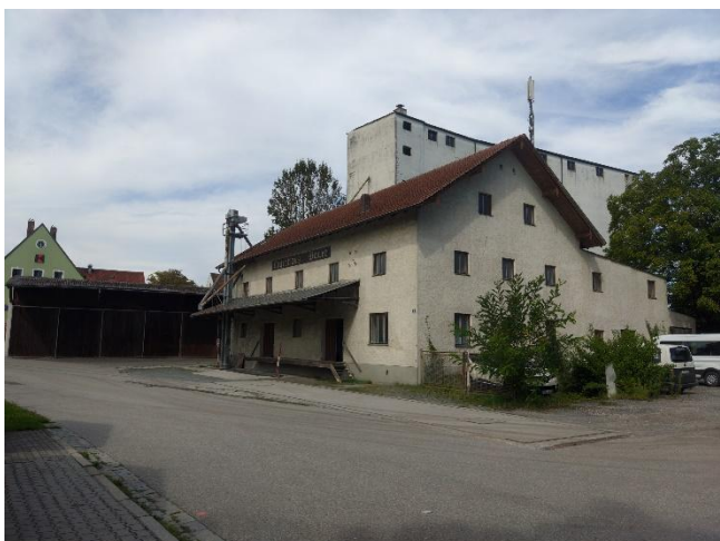
Abb. 3: Lagerhalle und Hochsilo im Hintergrund, Blick nach Nordost
