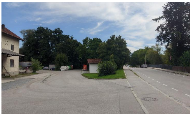
Abb. 2: Zufahrt zum Pfarrbrückenweg (rechts), Blick nach Süden
