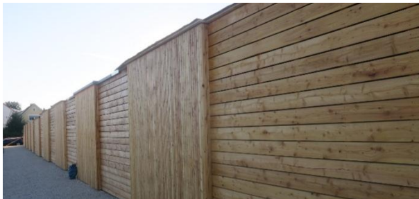
Abb. 7: Nordrand, Mauer 3 m hoch, mit neuer Holzverkleidung
