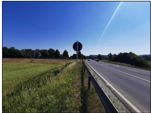
Abb. 2b: Böschung entlang der B 287 bei Abzweigung Kissinger Straße
