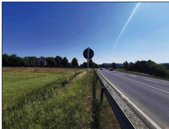
Abb. 2b: Böschung entlang der B 287 bei Abzweigung Kissinger Straße
