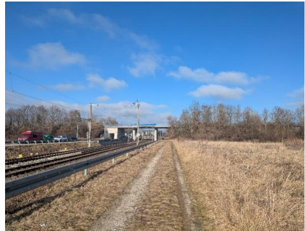
Abb. 6, Änderungsbereich nördlicher Teil, Blickrichtung Nordosten, Feb 2026 LaN
