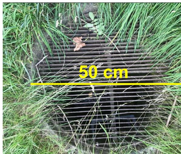
Abbildung 7.13: Ablauf in der Geländemulde in Breitötting
