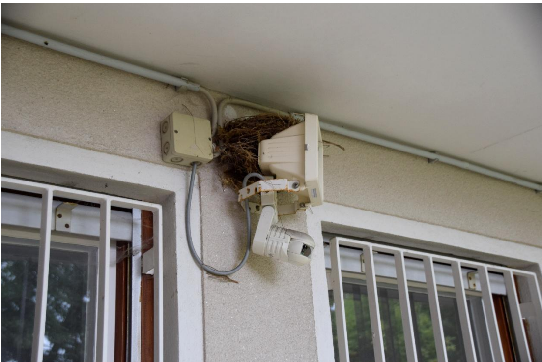
Abbildung 6: Vogelnest am Bestandsgebäude
