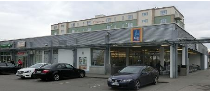
Abb. 8 Nahversorgungszentrum Centerville/Supply Center
